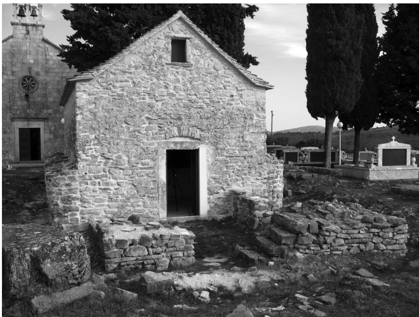
Crkva sv. Marije u Blizni Gornjoj, Zapadno pročelje s westwerkom
