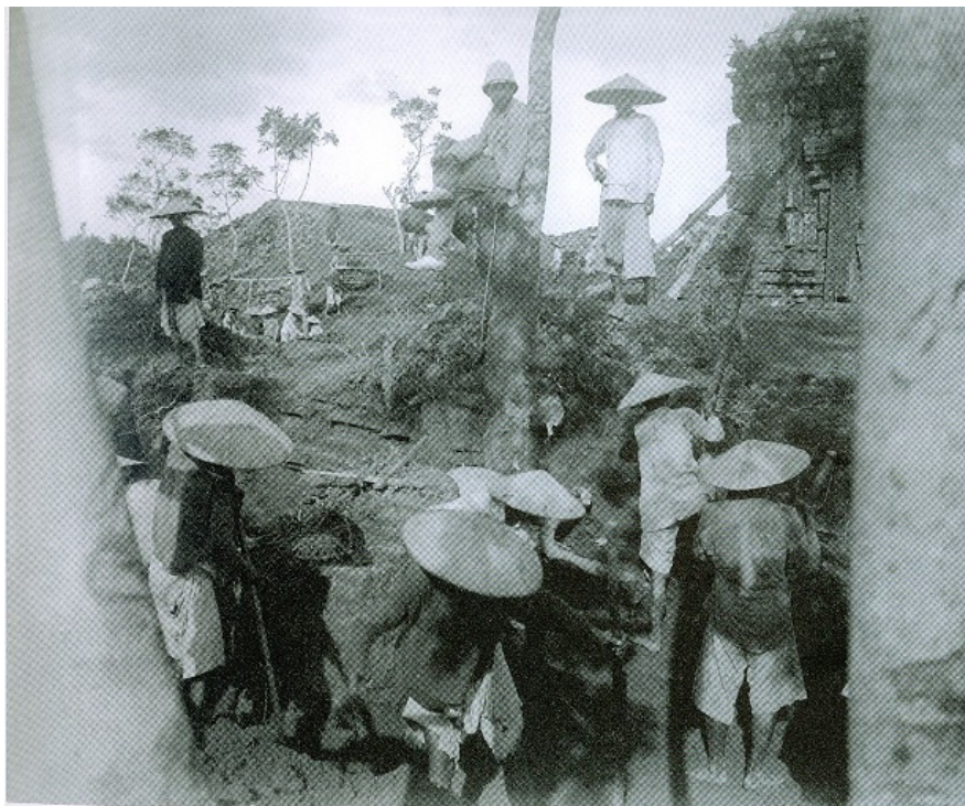
Fig. 24 Carpeaux surveying work at Đông Dương , 1902 (Ghesquière 2005: 133)
