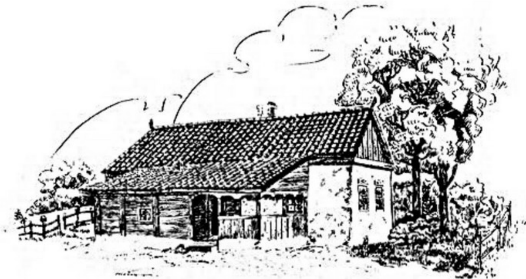
Рис. 1. Каркасный дом с плетневым заполнением. Конец XIX — начало XX в. Село Богатырь Донецкой области
