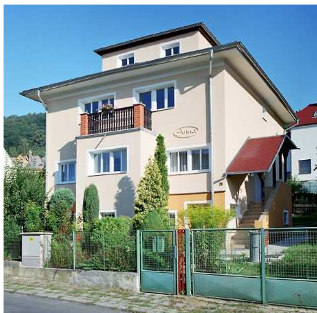
e) Obr. 5: Městské obytné domy v městské části Klíše (zdroj: Archiv města Ústí nad Labem)
