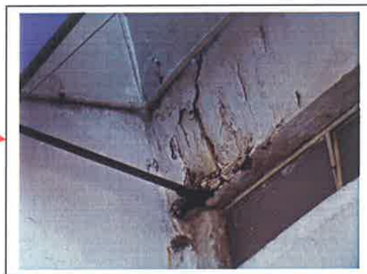
FOTOS 66 / 67: INFILTRAÇÕES E ARMADURA EXPOSTA
