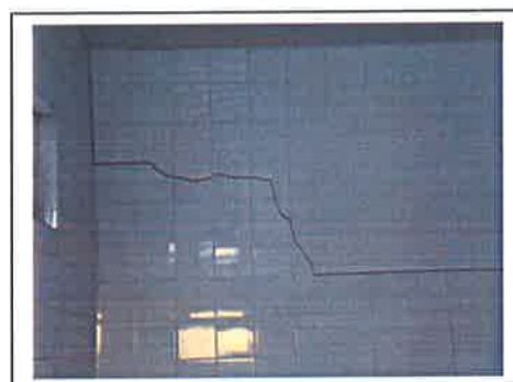
FOTOS 7 / 8: VITRO DO WC MASCULINO E TRINCA NO WC FEMININO
