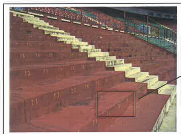
FOTOS 11 / 12: FISSURAS NO REVESTIMENTO
