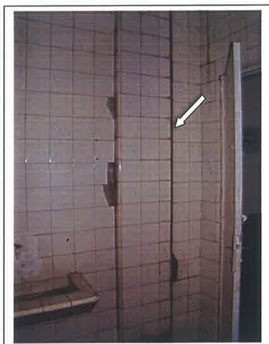
FOTOS 34 / 35: TRINCA NO WC MASCULINO E FALTA DE LADRILHOS NO WC FEMININO
