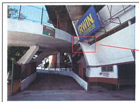
FOTOS 66 / 67: INFILTRAÇÕES E ARMADURA EXPOSTA
