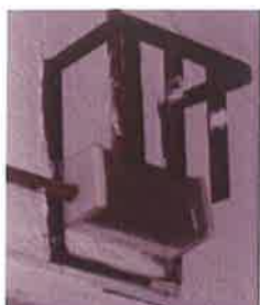
Foto 78: Apresenta iluminação de emergência necessitando de manutenção. Alojamento do Profissional
