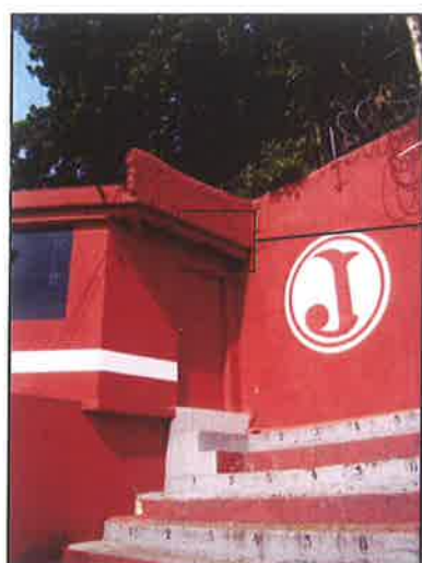
FOTOS 13 / 14: CABINE DE SOM COM ARMADURA EXPOSTA
