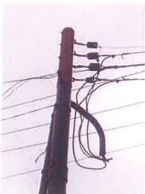
Foto 11: Entrada de Energia Secundária em boas condições de conservação e instalação. Entrada de Energia Secundária
