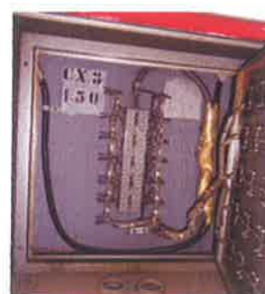
Foto 67: O quadro apresenta-se em boas Condições de instalação, Necessitando de limpeza interna. Entrada Principal
