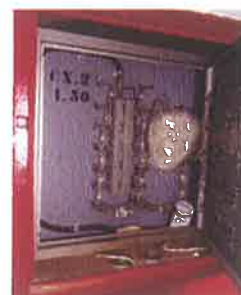
Foto 83: As estruturas de ligação com os blocos terminais estão em boas condições Quadro de conexão e Telefonia do Campo
