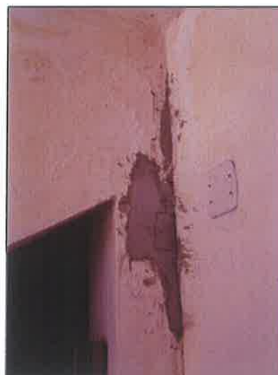
FOTO 49 / 50: TRINCA NA PAREDE DO SANITARIO MARCULINO ( Seção 2 e 3 )
