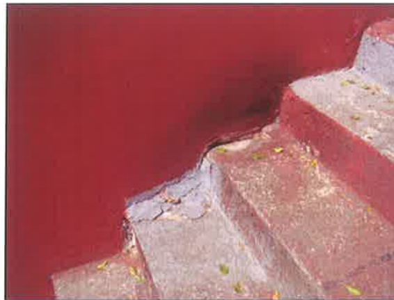
FOTOS 11 / 12: VISÃO GERAL DOS DEGRAUS E TRINCAS DE RECALQUE
