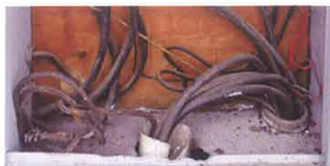
Foto 14: Estrutura interna necessitando de limpeza. Quadro de Medição/Proteção – Secundário
