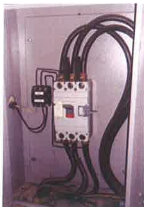
Foto 05: Disjuntor da bomba de incêndio devidamente identificado conforme norma. Quadro de Medição Principal
