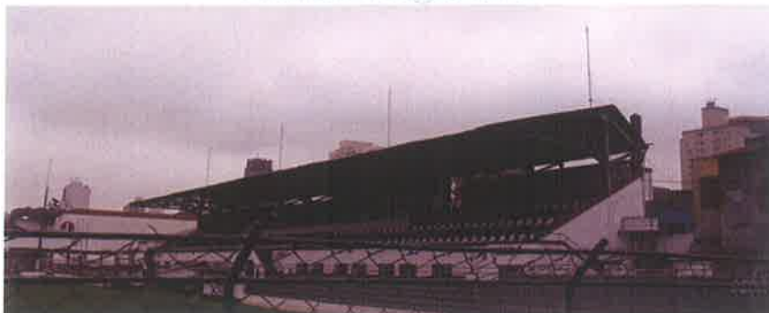
Foto 84: Foram instalados sistemas de proteção contra descargas atmosféricas junto ao estádio e apresentação do laudo de SPDA de forma a atender as exigências da Norma NBR 5419
