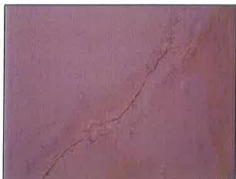
FOTO 49 / 50: TRINCA NA PAREDE DO SANITARIO MARCULINO ( Seção 2 e 3 )
