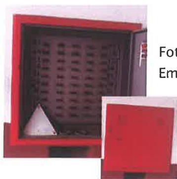
Foto 67: O quadro apresenta-se em boas Condições de instalação, Necessitando de limpeza interna. Entrada Principal
