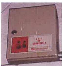
Foto 77: Apresenta iluminação de emergência necessitando de manutenção. Alojamento do Profissional
