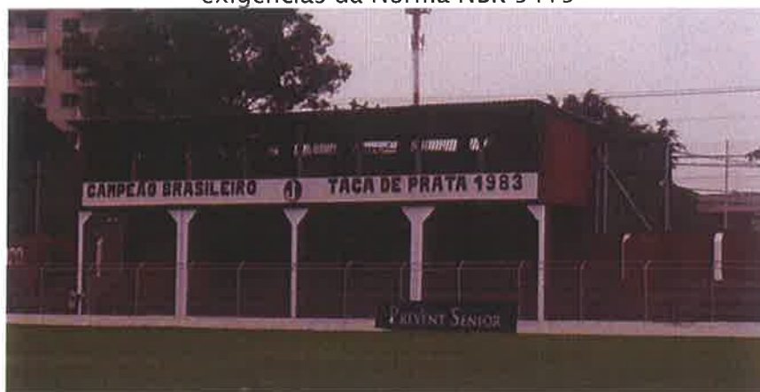
Foto 86: Foram instalados sistemas de proteção contra descargas atmosféricas junto ao estádio e apresentação do laudo de SPDA de forma a atender as exigências da Norma NBR 5419
