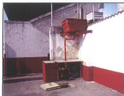
FOTOS 59 / 60: HIDRANTE E BOMBA DE INCÊNDIO.
