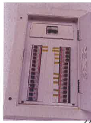
Foto 35: Quadro apresenta alguns componentes identificados necessitando de melhorias na identificação. Quadro de força – Iluminação Externa/Quadras
