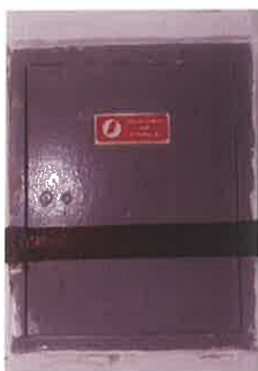
Foto 40: O quadro antigo deverá ser lacrado e identificado como caixa de passagem. Quadro de força - Cozinha
