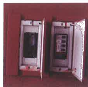
Foto 58: Deverá ser providenciado fechamento das partes vivas do painel e identificação dos componentes.
