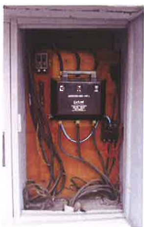
Foto 14: Estrutura interna necessitando de limpeza. Quadro de Medição/Proteção – Secundário
