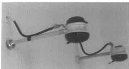
Foto 50: Chuveiros em boas condições de instalação. Vestiário do amador
