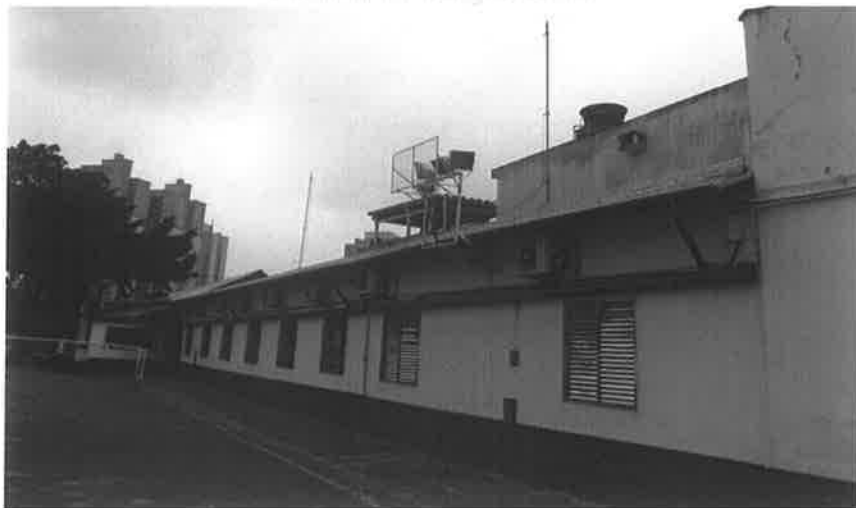
Foto 87: Foram instalados sistemas de proteção contra descargas atmosférica junto ao estádio e apresentação do laudo de SPDA de forma a anteder as exigências da Norma NBR 5419
