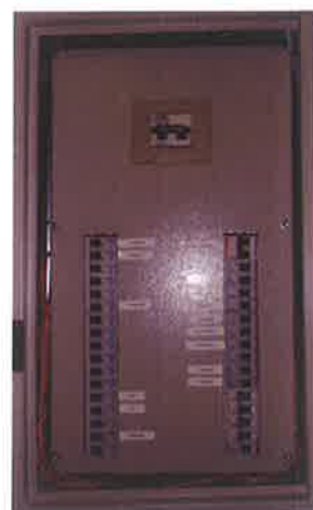
Foto 40: O quadro antigo deverá ser lacrado e identificado como caixa de passagem. Quadro de força - Cozinha
