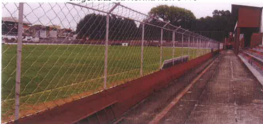
Foto 85: Foram instalados sistemas de proteção contra descargas atmosféricas junto ao estádio e apresentação do laudo de SPDA de forma a atender as exigências da Norma NBR 5419
