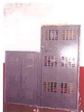
Foto 06: Caixa de e nova e em boas condições de uso e operação. Quadro de Medição Principal
