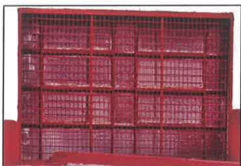
FOTOS 42 / 43: DISPOSITIVOS DE PROTEÇÃO DOS VITRÔS E DA ENTRADA DO VESTIÁRIO DOS VISITANTES.
