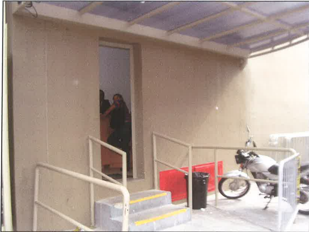
Foto 08 – Falta de placa com capacidade do estádio na entrada do portão principal.
