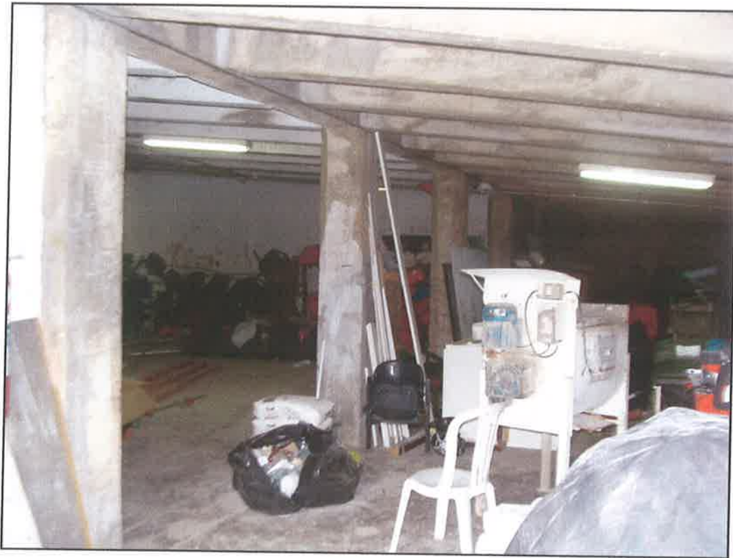
Foto 10 – Vista do depósito da rampa, necessitando de melhora no arranjo físico.
