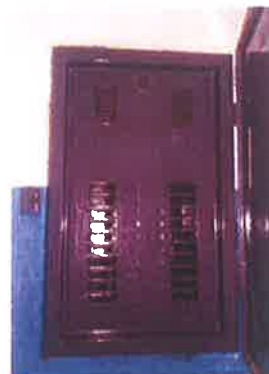
Foto 48: Identificação precária junto à placa de proteção. Vestiário dos Visitantes
