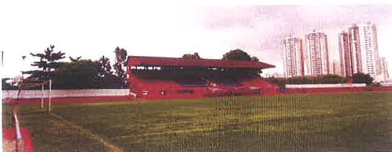
Foto 100: Arquibancada descoberta próxima ao placar. Verificação da Área de Cobertura do SPDA
