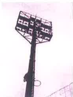
Foto 89: Estrutura suporte de Iluminação não apresenta Luminárias Torre de Iluminação 2.
