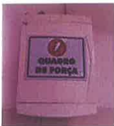
Foto 36: Quadro com placa de aviso de equipamento energizado e sem identificação funcional. precária, deve atender a norma NR10. QFL01 – Vestiário Local
