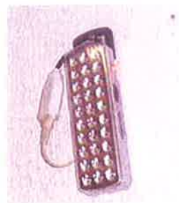
Foto 46: Apresenta Luminária de emergência em conformidade com a norma NBR10989. Vestiário Local
