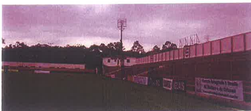
Foto 99: Arquibancada descoberta. Verificação da Área de Cobertura do SPDA
