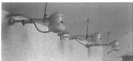
Foto 60: Chuveiros em boas condições de instalação.
