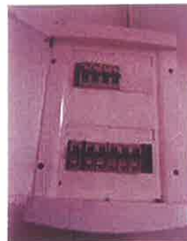
Foto 36: Quadro com placa de aviso de equipamento energizado e sem identificação funcional. precária, deve atender a norma NR10. QFL01 – Vestiário Local
