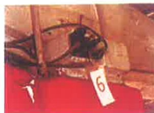
Foto 76: Apresenta pontos de conexão sem intraestrutura em quadro para interligação de telefonia Telefonia - Cabine de Imprensa
