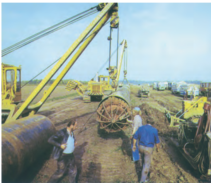
Будівництво газопроводу «Дружба», що проліг через землі Олександрівщини
