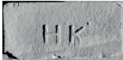
Ил. 20. Опукле клеймо на цеглі невідомого виробника
