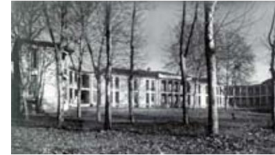
Padiglione Birago di Vische - alla sinistra, vista dal parco sul lato Dora; si notano i loggiati per la terapia della "cura d'aria" per i tubercolotici, chiusi nella ristrutturazione del 2000
