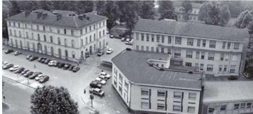
La palazzina della Direzione, la radiologia, i laboratori e il padiglione De Mattia , costruiti negli anni '50-'60 (foto del giugno 1985)
