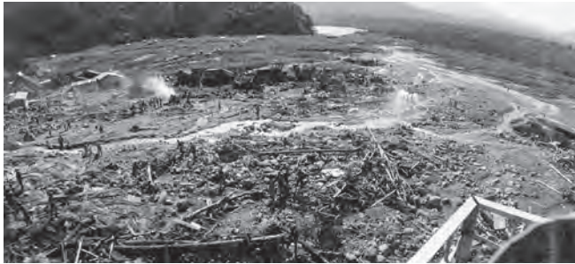
昭和41年（1966）の足和田災害の被害写真
