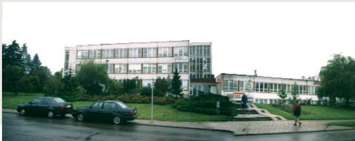
Blick von der Rahstedter Straße auf den Bestand der ehemaligen Poliklinik
