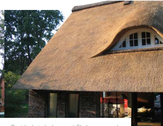
Reetdacheindeckung mit Fledermausgaube
