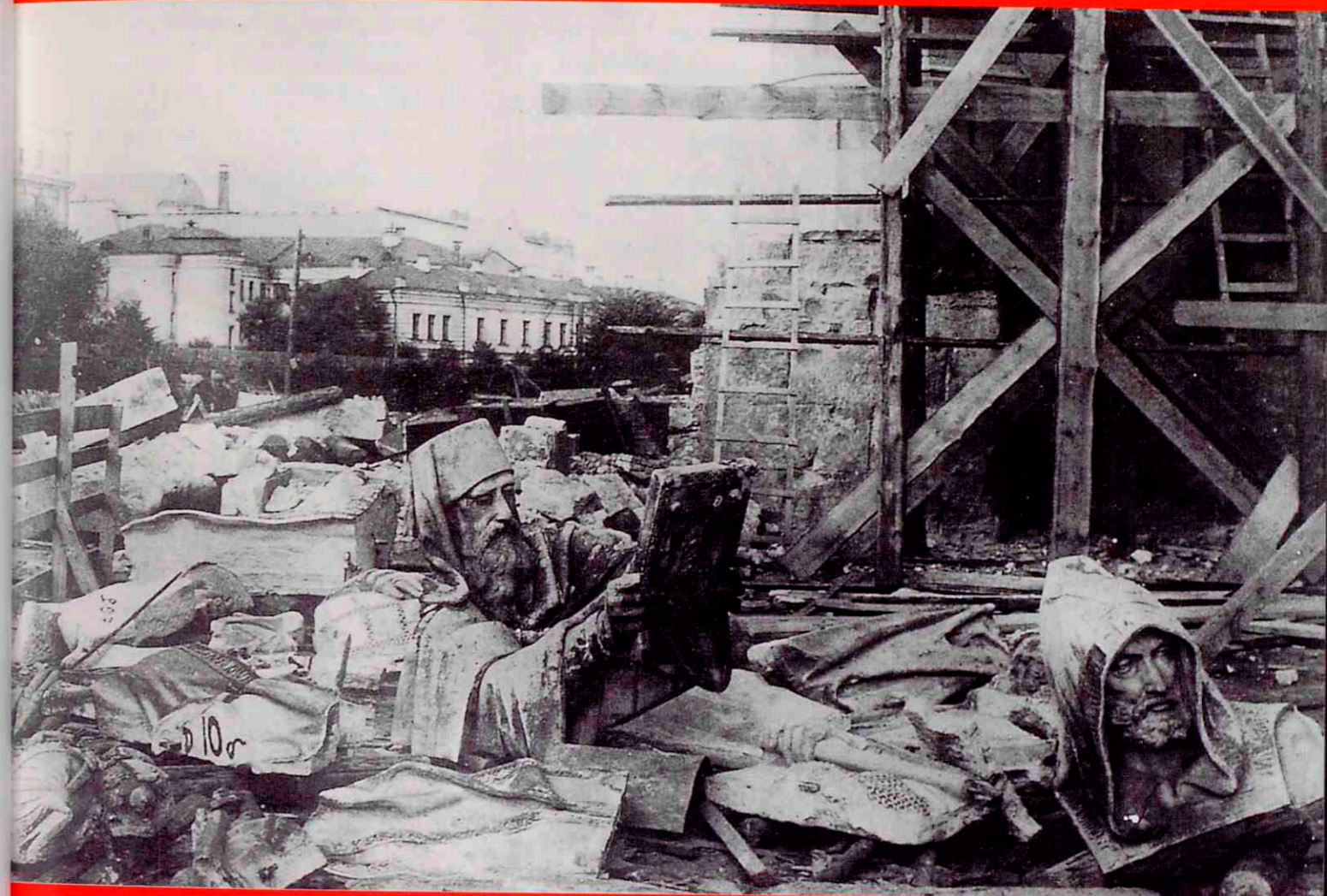
Vladislav Mikosha: Demolició de la catedral de Crist Salvador, Moscou (1931).
