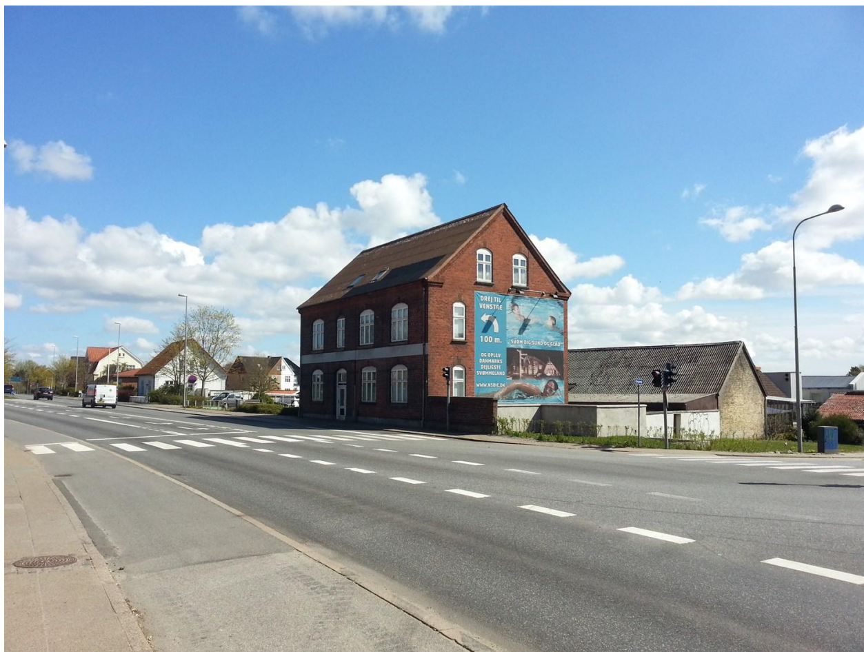
Eksisterende ejendom langs Østergade og hjørnet Østergade/Engvej
