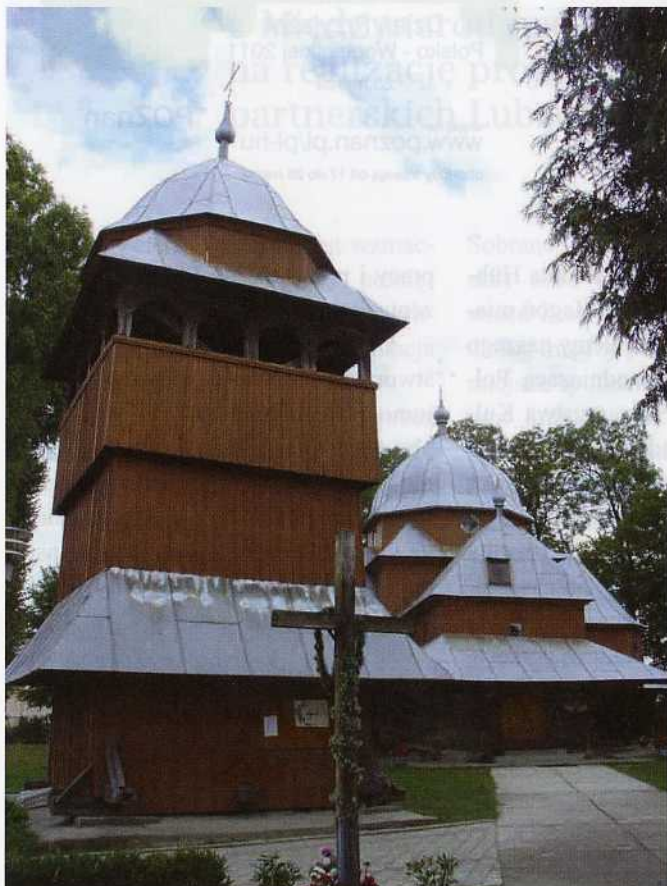
Cerkiew Narodzenia NMP w Jaworowie, 1670r., rozbudowana w 1939r.
