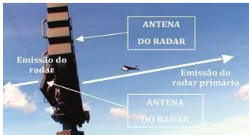
Figura 16 - Antenas do radar primário e IFF solidárias
