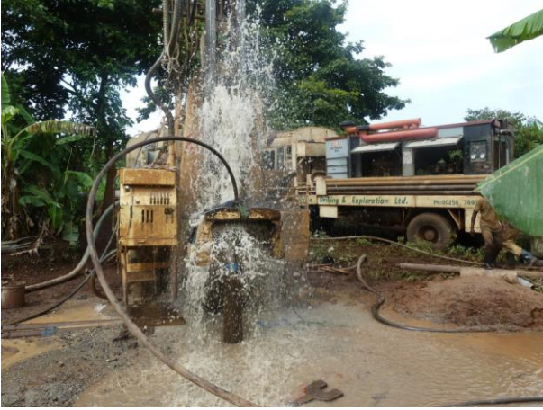
Développement d'un piézomètre Gf-F1bis à Gihofi
