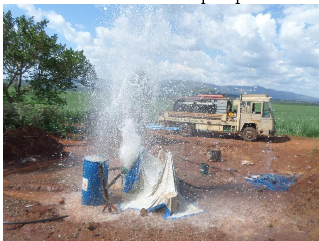
Figure 31 : Développement d'un piézomètre Gf-F1bis à Gihofi
