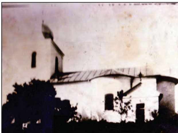
Fig. 10 – Aspect al bisericii după reabilitarea din 1955 – fațada sud
