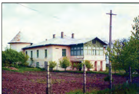
Foto 3. Fațada laterală stânga corpul principal
