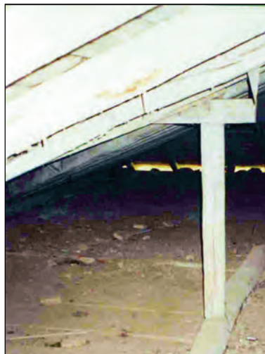
Foto 7. Structura podului la corpul principal
