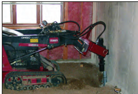
Fig. 6: montaj la interior
