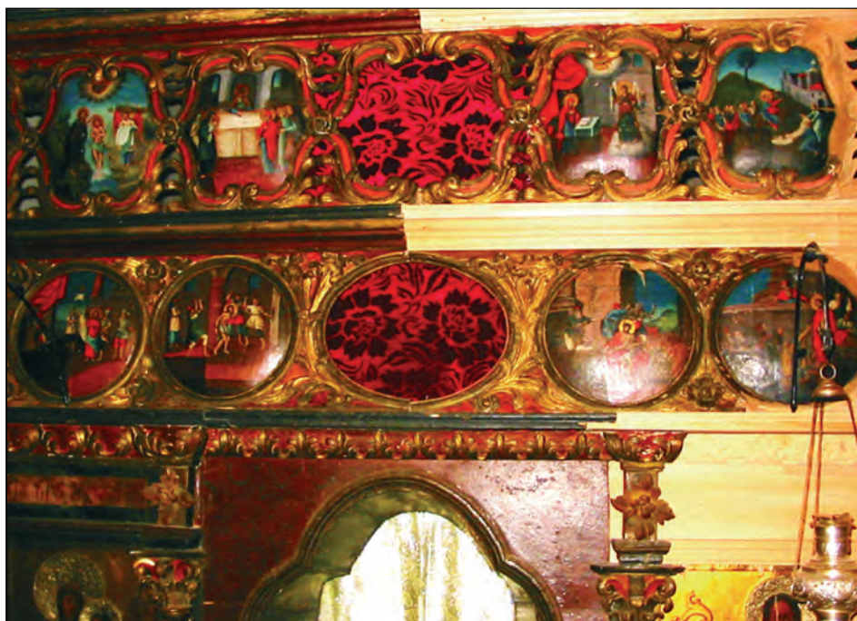
Partea centrală a iconostasului în timpul completărilor zonelor distruse la incendiu
