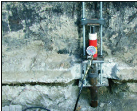
Fig. 7: liftarea fundației la poziția inițială
