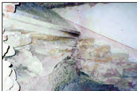
Foto 17. Scara de acces demolată. Se observă urmele treptelor de piatră.
