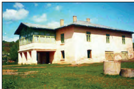
Foto 2. Fațada laterală dreapta - corpul principal
