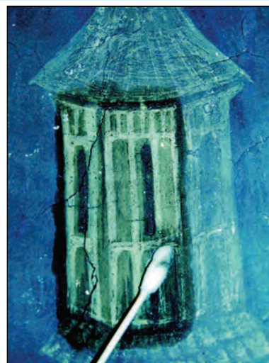
Foto 13. Detaliu cu turla bisericii-chivot, curățire locală folosind soluții aplicate cu vată de bumbac sterilă fixată pe bastoncini.
