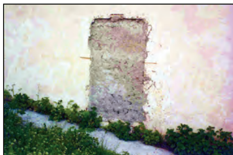
Foto 18. Zidirea golului de fereastră al „camerei reci” din vecinătatea beciului, pe fațada laterală
