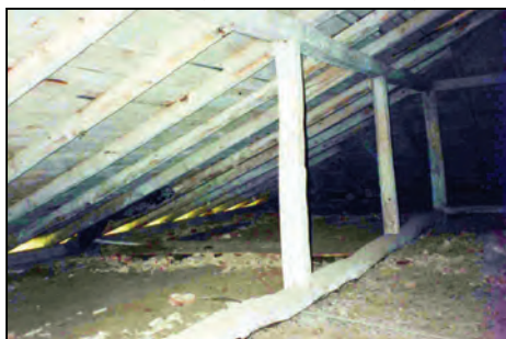
Foto 15. Structura șarpantei pe scaune realizate din tălpi, popi și pane de lemn
