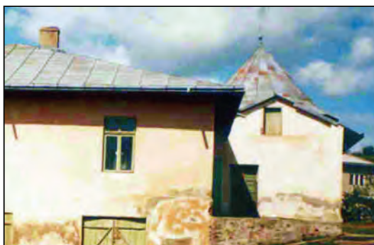
Foto 8. Anexa - fațada laterală dreapta
