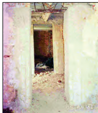
Foto 21. Intervenții prin turnare de beton la golurile de uși
