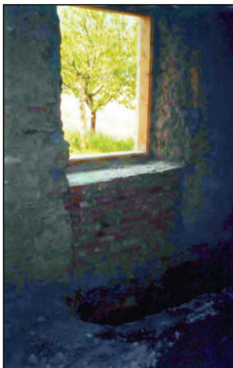
Foto 19. Transformarea prin zidire a unui gol de fereastră în gol de ușă pe fațada principală
