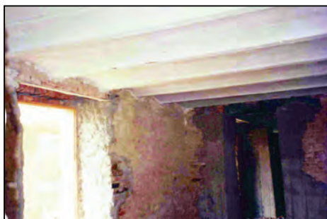
Foto 13. Planșeele realizate în sistem bolțișoare de cărămidă pe profile metalice
