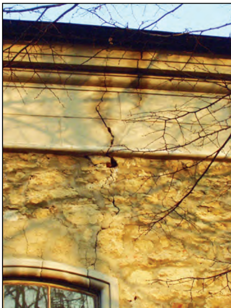
Fig. 15 – Fisură în dreptul pronaosului – fațada sud
