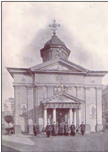
Fațada exterioară inițială
