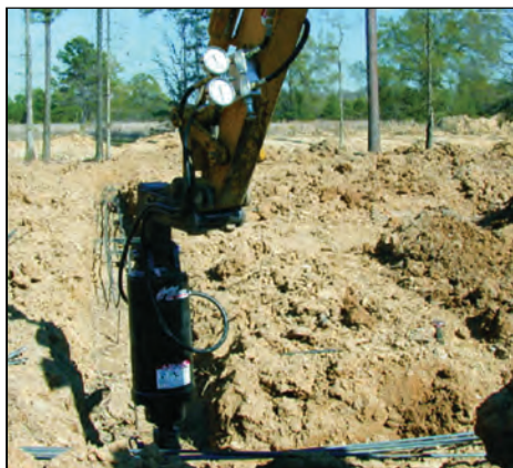
Fig. 9: monitorizarea torsiunii (manometre)
