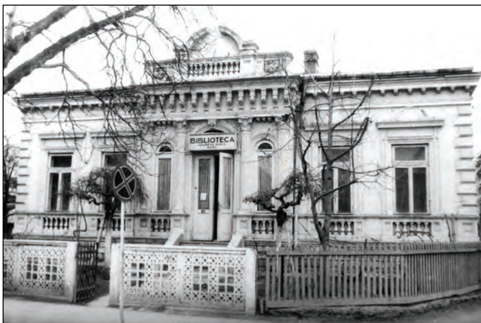
Fig. 7 - Banca „Albina” - fațada principală (foto 1989)
