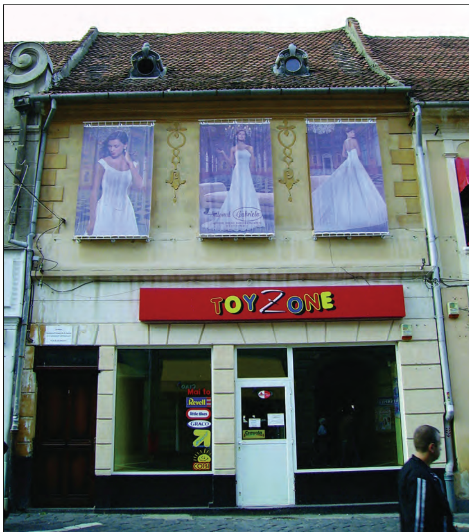
Strada Republicii nr. 7. Reclamele acoperă fațada casei
