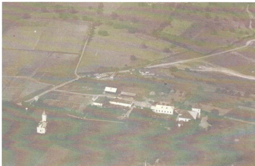
Fig. 11 - Reședința de la Miroslava vedere aeriană, 1917.
