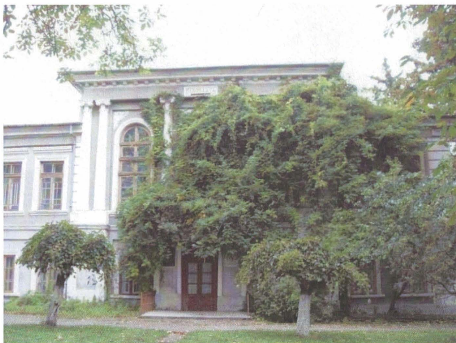
Fig. 1 – Palatul de la Miroslava. Fațada principală.
