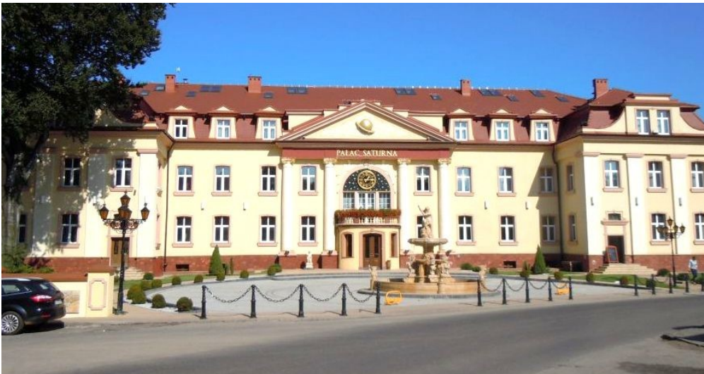
Zdjęcie nr 21. Budynek dyrekcji kopalni „Saturn”, obecnie Pałac Saturna - Termy Rzymskie, ul. Dehnelów 2, , źródło: karta GEZ Czeladź, autor Ryszard Dobiega
