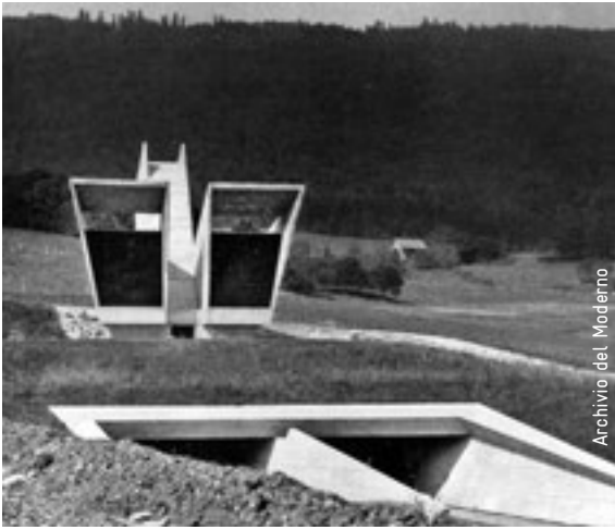
L'autoroute A16 Transjurane. Vue de la centrale de ventilation et de l'entrée du tunnel à Terri Nord
