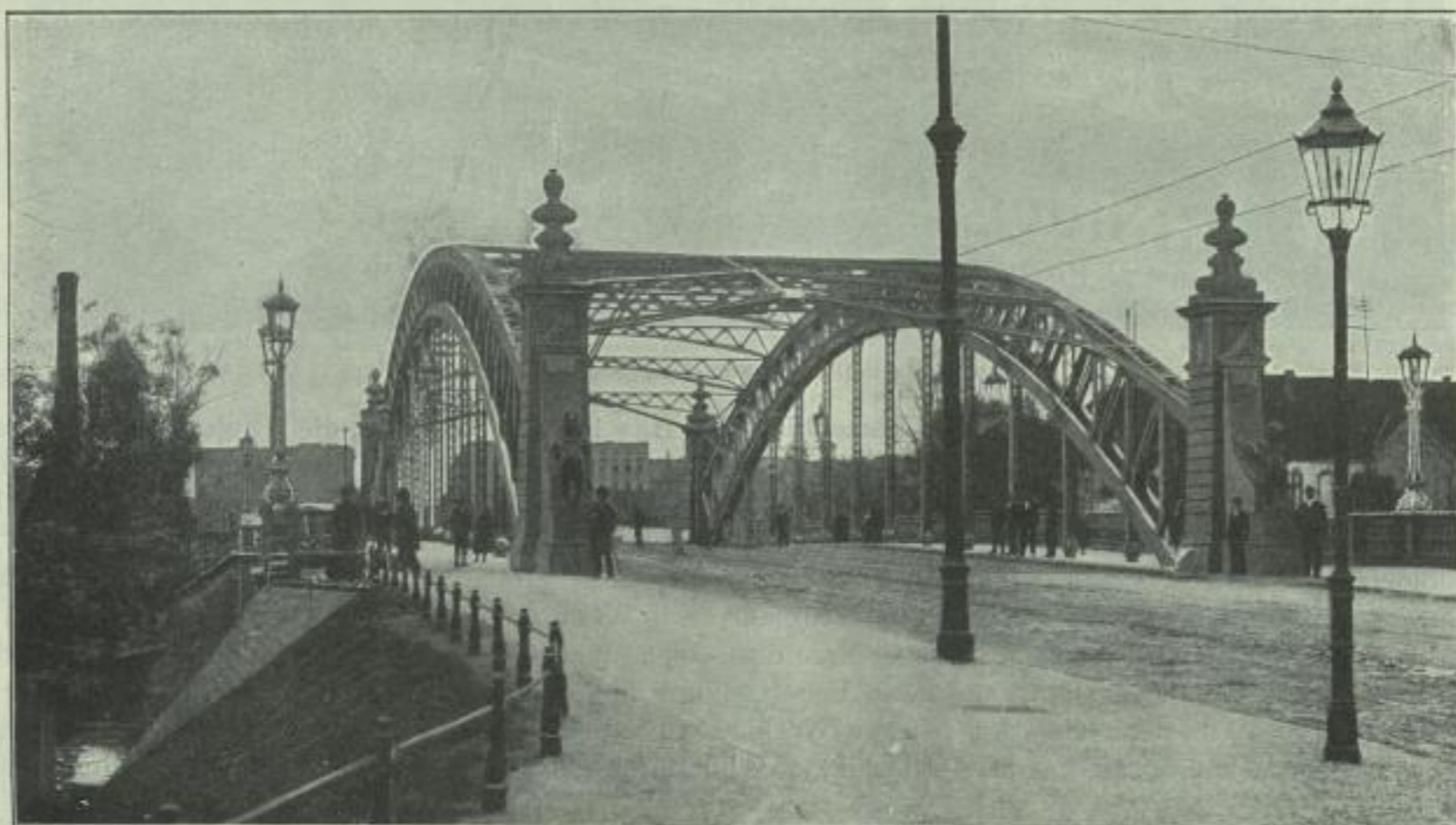
Schloßbrücke über die Spree zu Charlottenburg bei Berlin.
