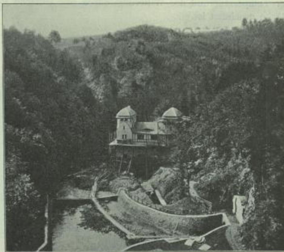
Abb. 20. Elektrizitätswerk und Auslauf der Umlaufstollen.
