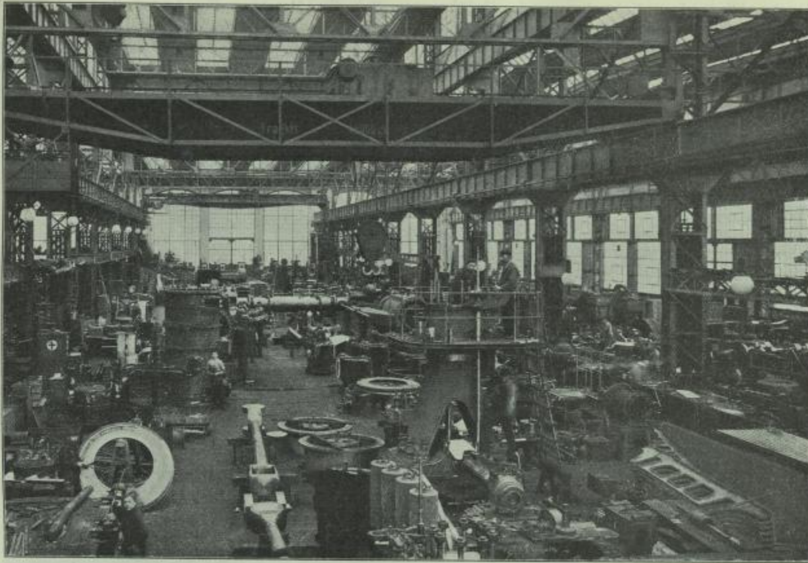
Montagehalle für große Maschinen, westlicher Teil.
