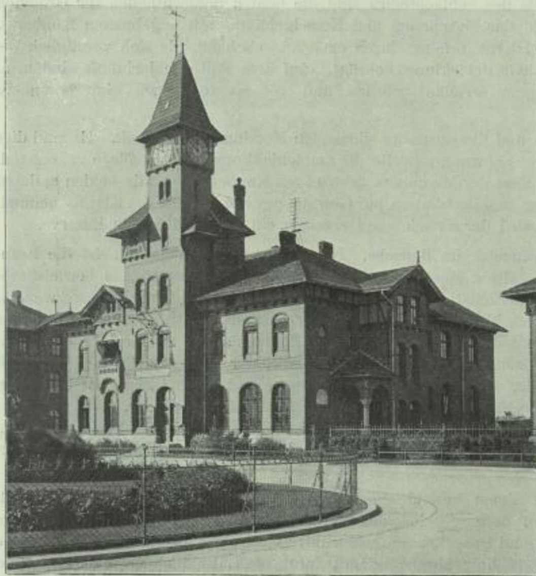
Ansicht des Verwaltungsgebäudes.
