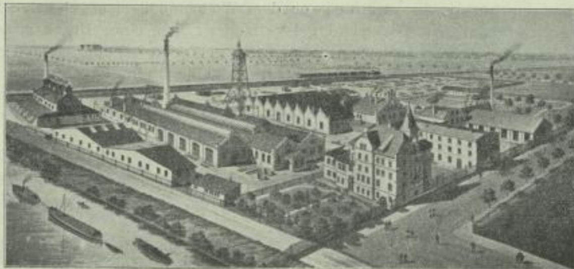
Gesamtansicht der Fabrikanlage.
