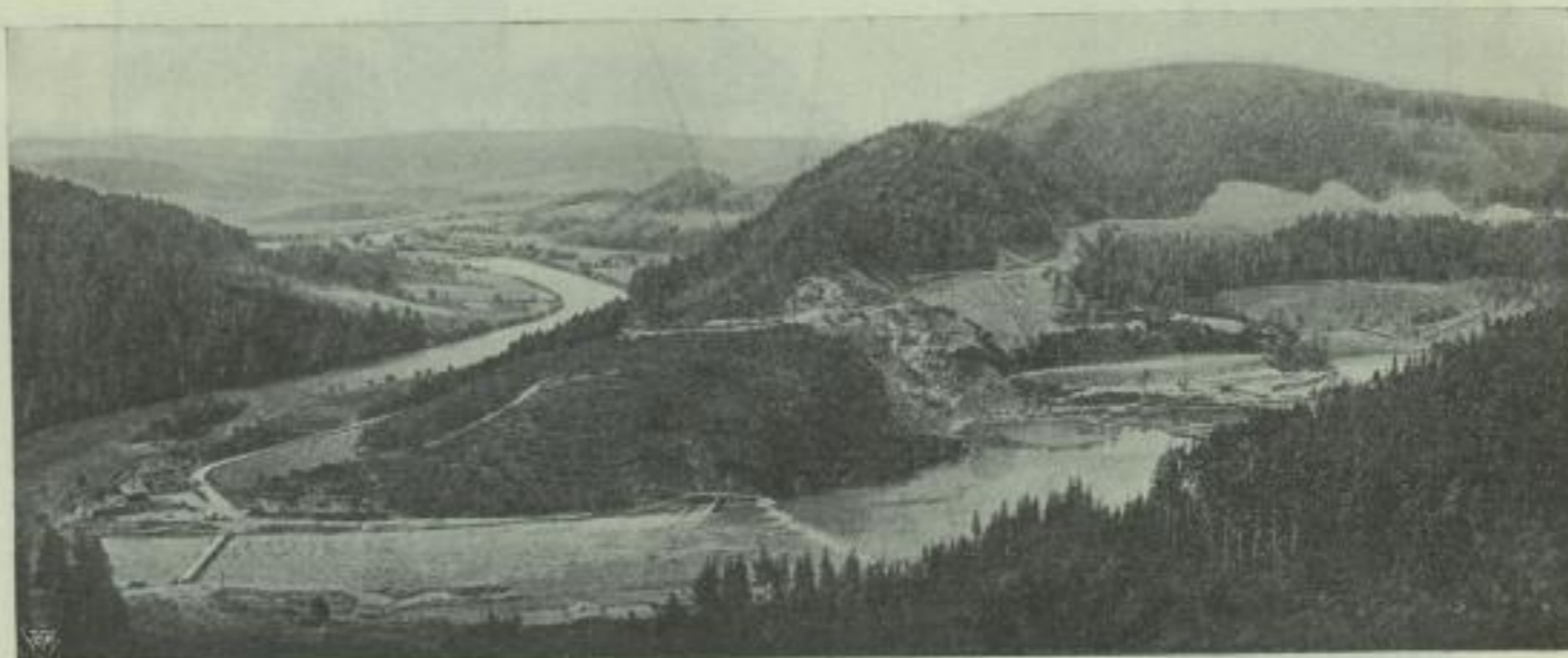
Abb. 21. Uebersicht der Baustelle der Talsperre bei Mauer.
