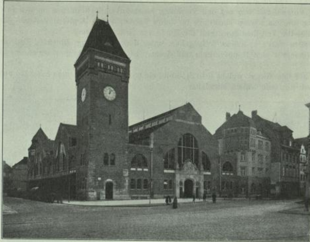
Ansicht der Halle I.
