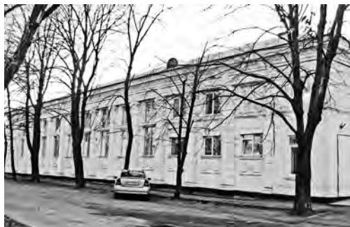
Спорткомплекс (бічний фасад)
