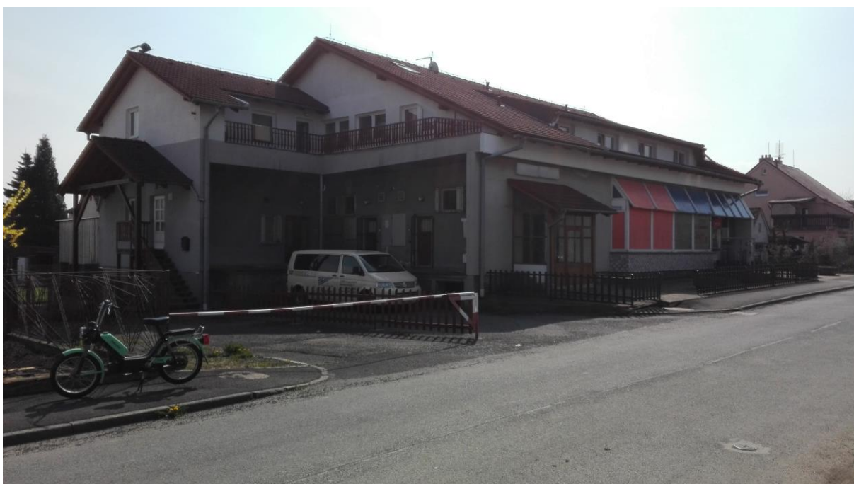
Příloha č. 27: Budova bývalé prodejny Pramen.
