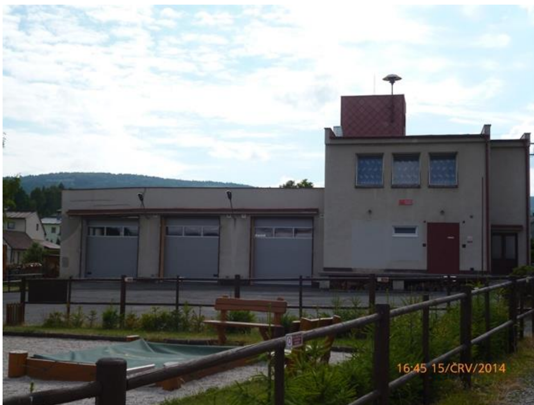
Příloha č. 30: Budova hasičské zbrojnice.
