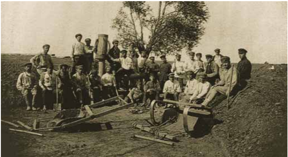
Будівництво залізниці. 1915 р.
