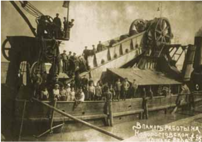
На спорудженні Новоростовського каналу. 1928 р.
