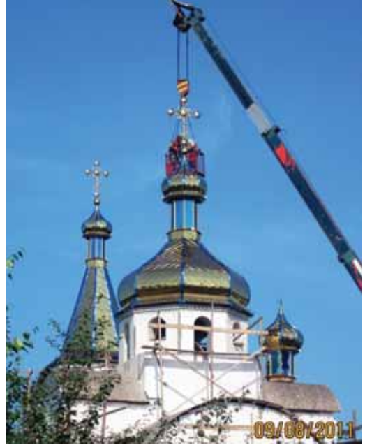
Встановлення хреста на новій будівлі Свято-Михайлівської церкви
