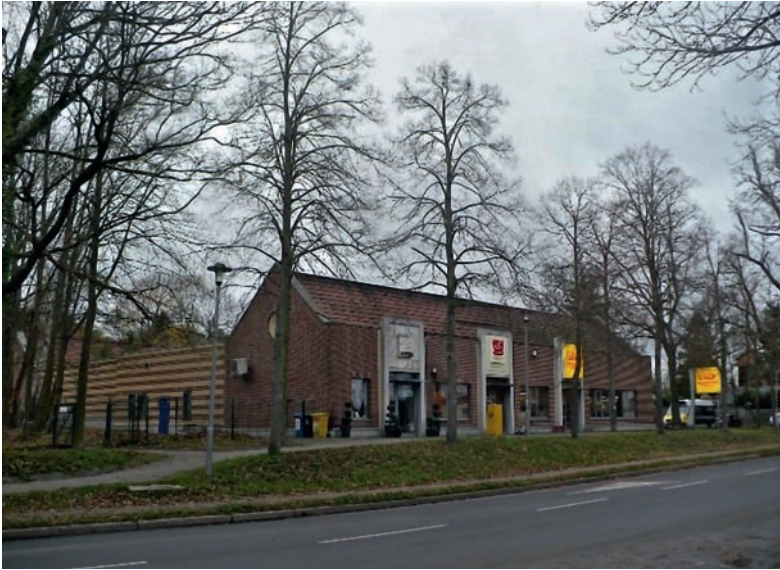
Abb. 29: Blick auf den ehemaligen Standort von St. Raphael mit der heutigen Bebauung (November 2017).
