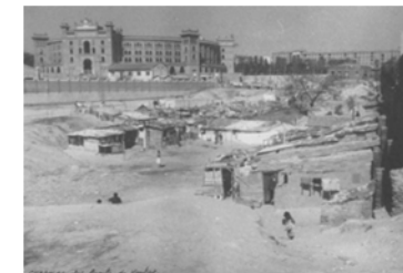
Chabolas del Puente de Ventas, 1950
