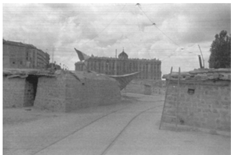
Defensas fortificadas cerca del Palacio de Oriente.
