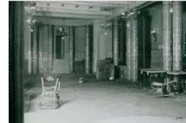
Interior de la checa instalada en el Círculo de Bellas Artes
