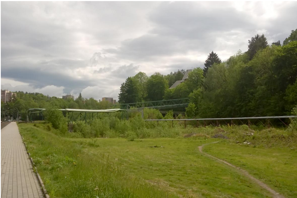
Obrazová příloha č.7: Území Textilany s vyšlapanými cestičkami od chodců, 2019. Zdroj: vlastní
