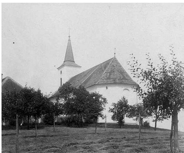
Pohled na exteriér bývalého farního katolického kostela sv. Prokopa Opata v Touchořínách, (zbořeno 1984). Foto: archiv Biskupství litoměřické.
