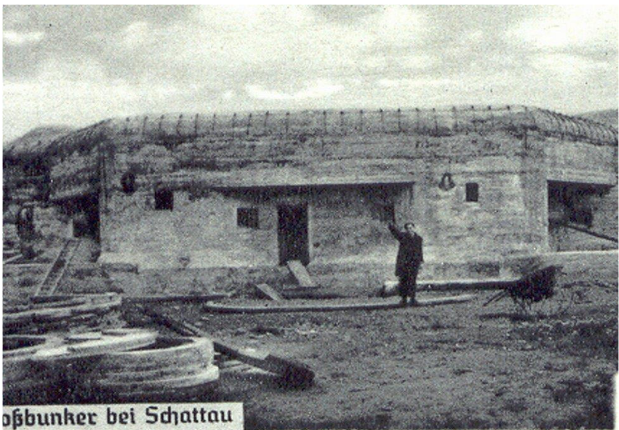
Obrázek 6: Výstavba československého opevnění v Šatově v roce 1938 (zdroj: osobní archiv Miloslavy Klímové).
