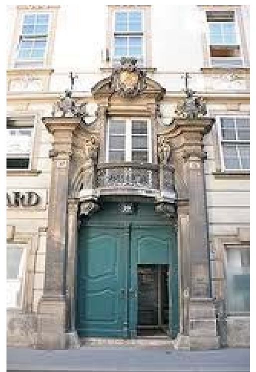
Obr. 23 Portál bývalého paláce Orsini-Rosenberg, Vídeň
