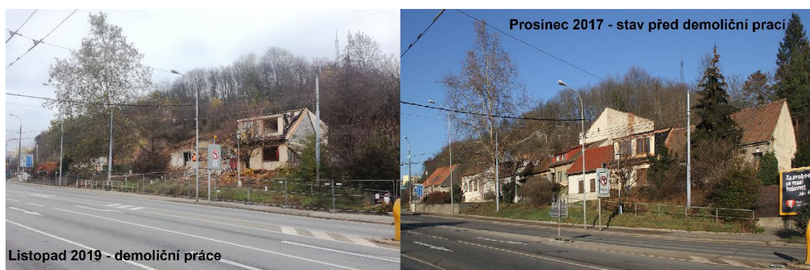
Obr. 9 Kolonie Pod kopcem v roce 2019 v průběhu demoličních prací a ve stavu před demoliční prací v roce 2017 (zdroj: Foto FRANC, 2019; KALINA, 2014)
