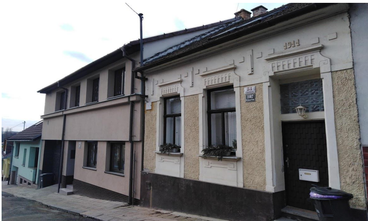
Obr. 17 Zrekonstruované dělnické domky na ulici Fibichova, dříve Hálkova (zdroj: Foto autorka, 2020)
