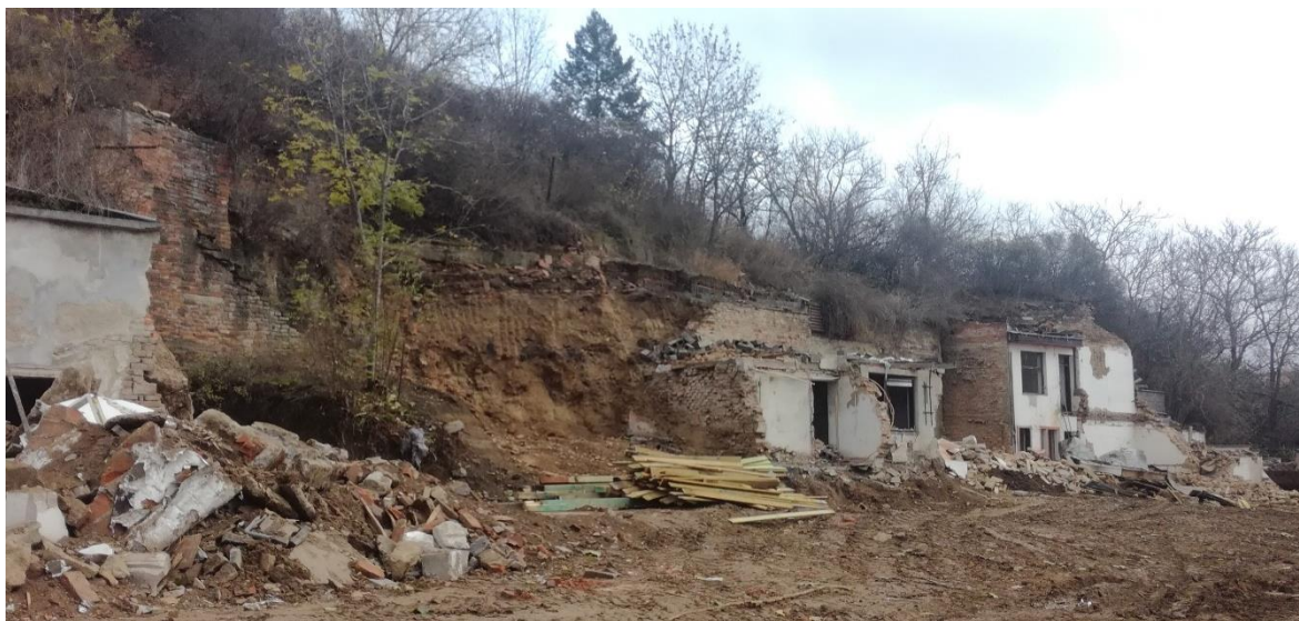
Obr. 10 Demoliční práce na ulici Provazníková, stav v listopadu 2019 (zdroj: Foto FRANC, 2019)
