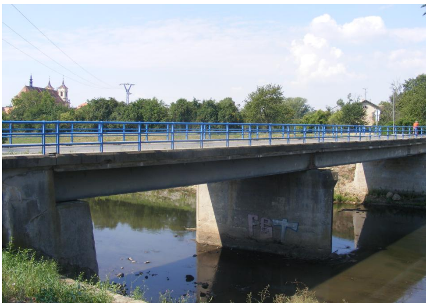
[8c] Dnešní stav rajhradského mostu (vlevo vzadu klášter)
