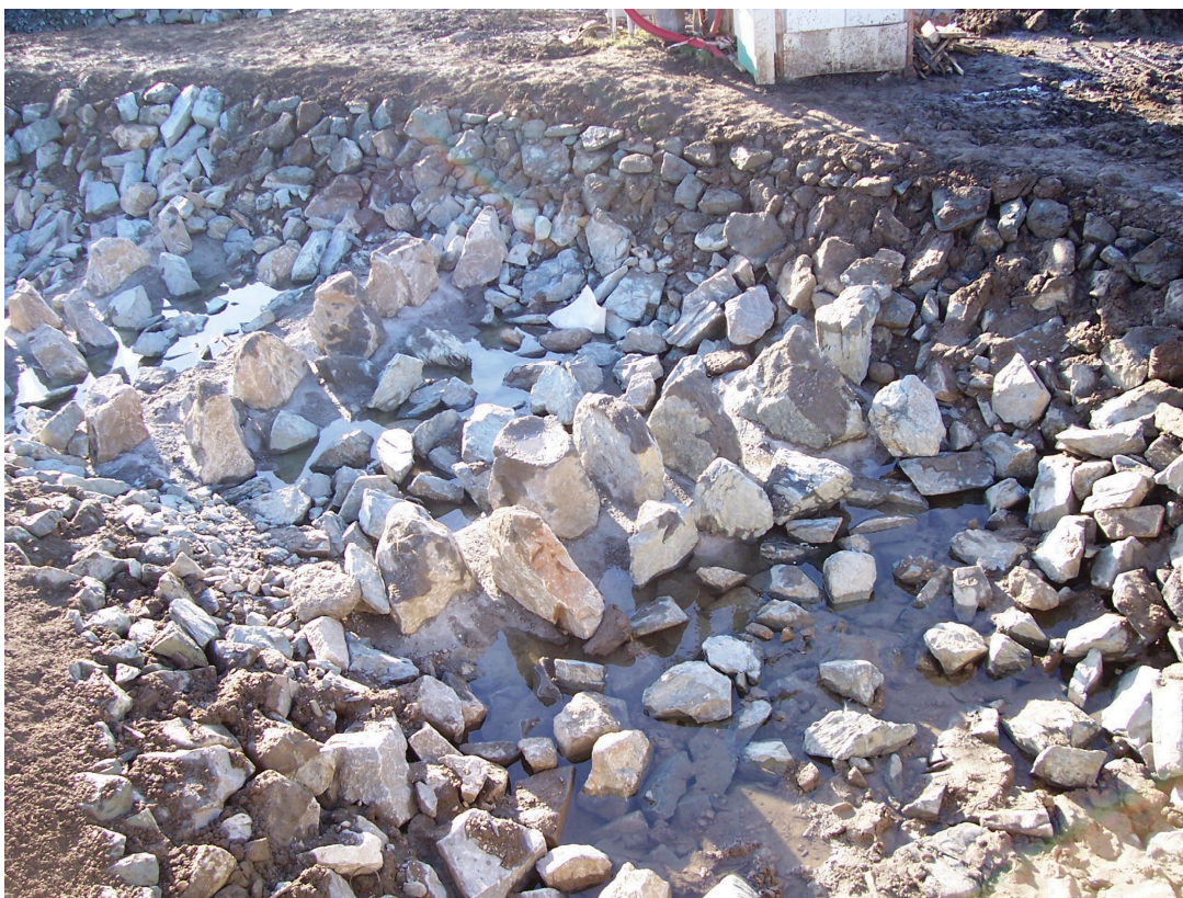
Foto. 2. Detail příčných přehrádek oddělující jednotlivé bazénky. Fotografie byla pořízena těsně před zprovozněním přechodu.
