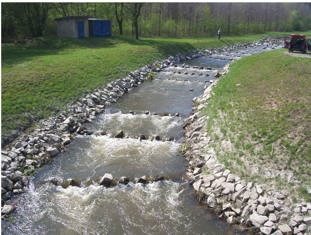
Foto. 7. Dolní část přechodu se břehy zarůstající vegetací.
