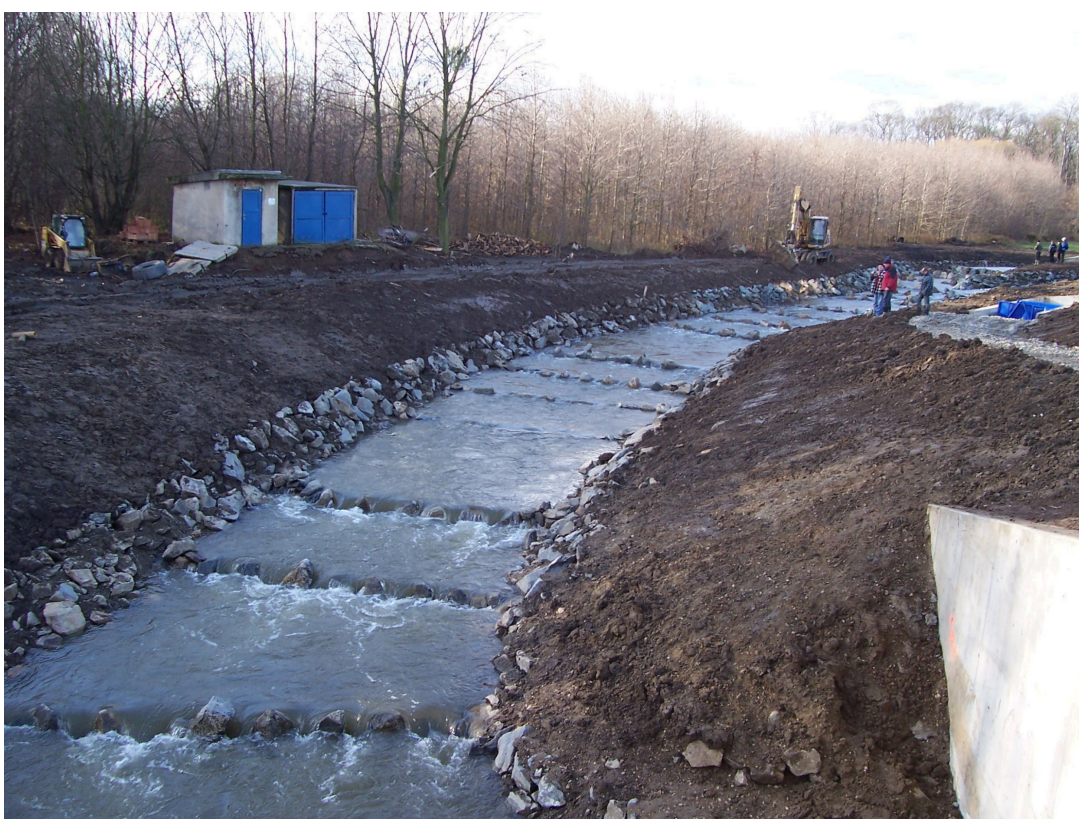
Foto. 4. Pohled na dolní úsek přechodu po zprovoznění.
