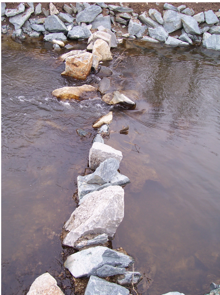
Foto. 5. Detailní pohled na jednu z mnoha příčných přehrádek po uvedení rybího přechodu do provozu.
