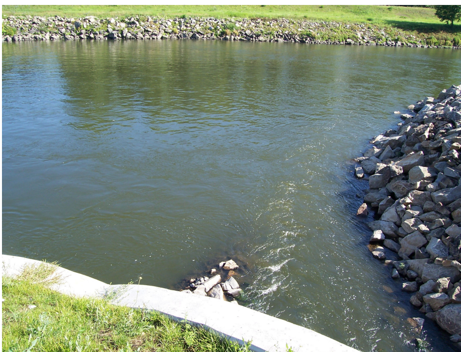
Foto. 6. Detail atraktivního proudu, který navádí ryby do tělesa rybího přechodu.
