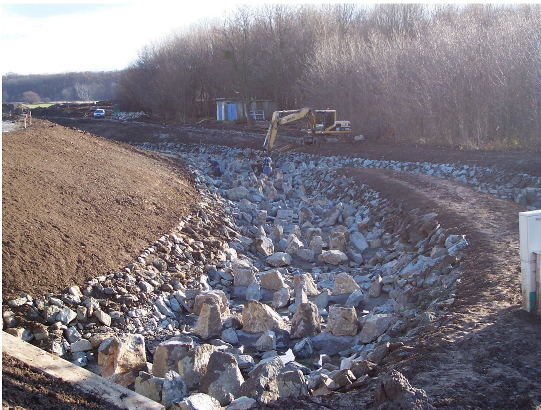
Foto. 1. Poslední úpravy rybího přechodu těžkou technikou na podzim 2007.
