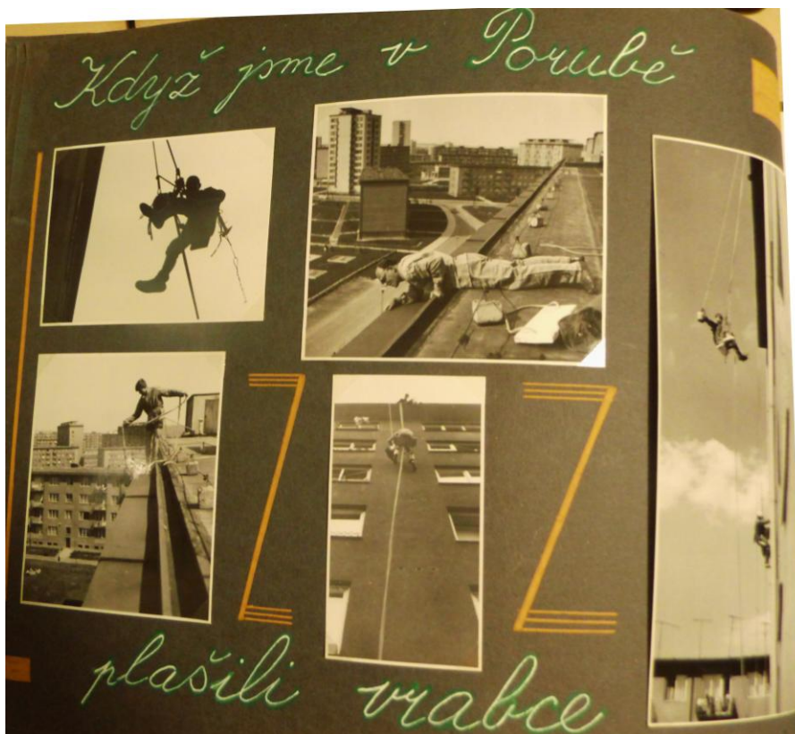
Obrázek č. 5: Fotokronika: První Výškové práce v Ostravě-Porubě, výměna víček.
