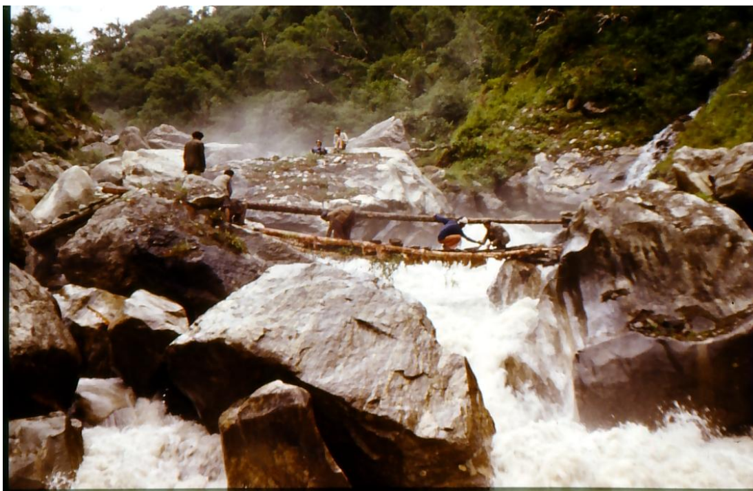
Obrázek č. 29: Výroba provizorního mostu přes řeku Riši. Foto: archiv Jan Marek.
