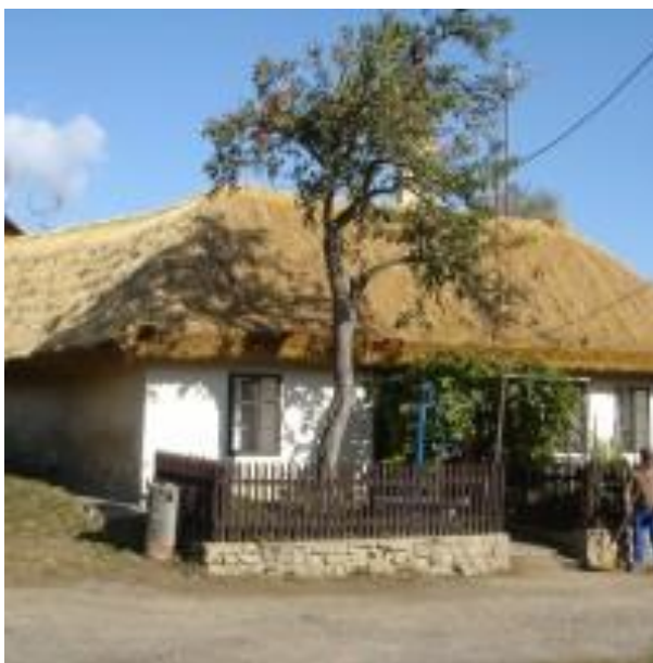
Obr. 7 Došková chalupa v Petrovících
