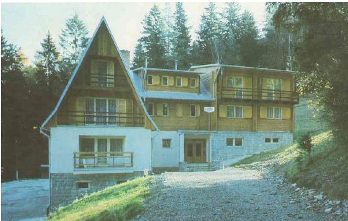
Příloha č. 31: Objekt dřívějšího rekreačního a školícího zařízení pro zaměstnance firmy Tylex ve Svojanově
