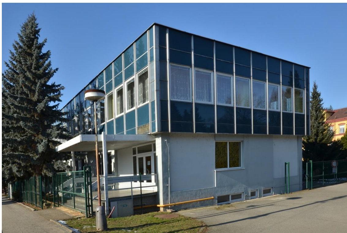
Příloha č. 37: Zrekonstruovaná budova jídelny a kuchyně
