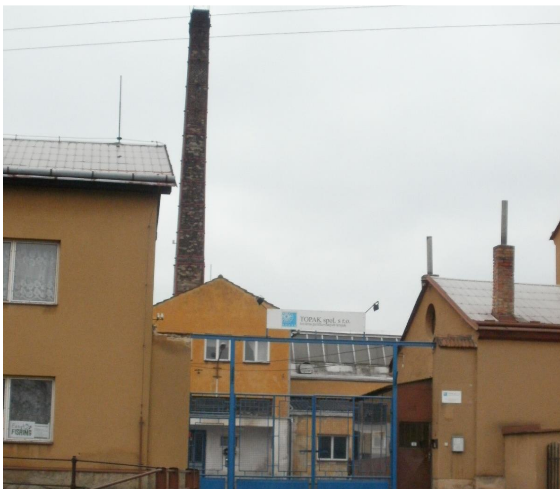
Obrázek 13 Pohled na část továrních budov Topak v Drnovicích (foto autor)
