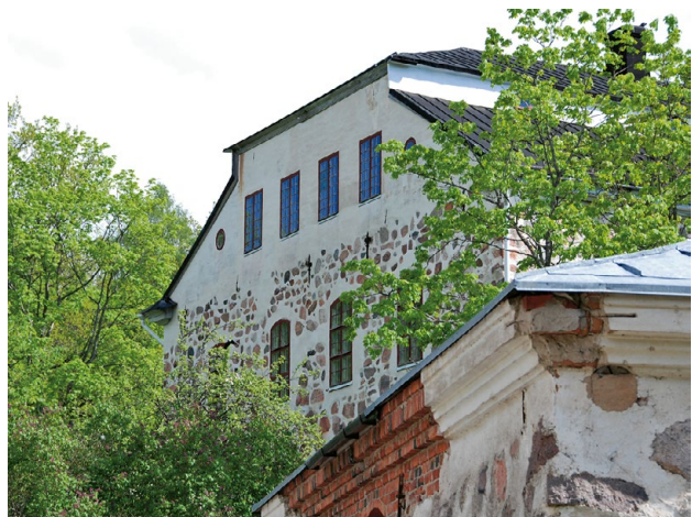
■ Sjundbyn kartanon keskiaikainen kivilinna sijaitsee Siuntiossa.
