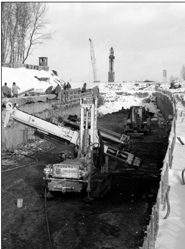
Obr. 2 – Provádění vrtu pro kotvu
