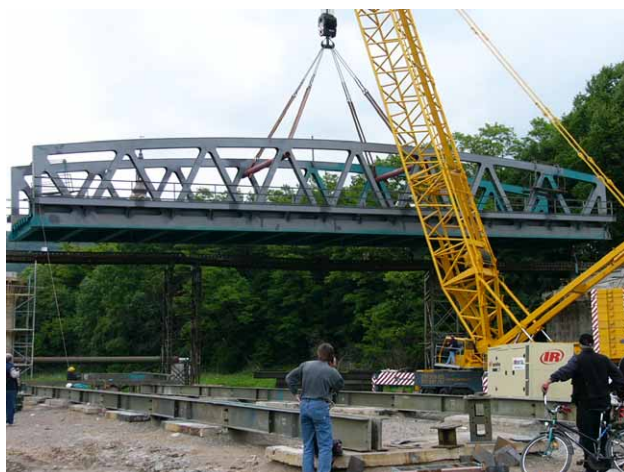
Montáž ocelové konstrukce – fáze 2
