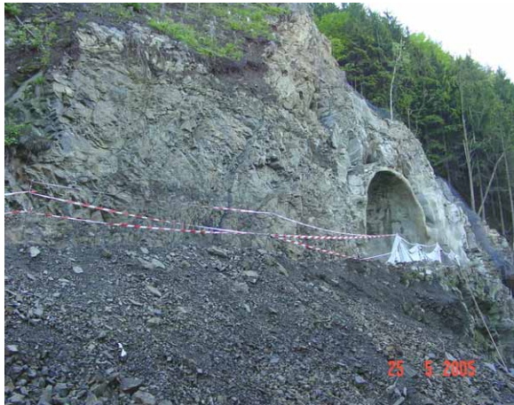
Obr. 3. Vjezdový hloubený úsek tunelu Hněvkovský II.
