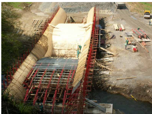
Bednění nosné konstrukce
