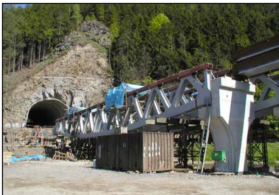
Obr. 8 Osazené konstrukce hlavního pole
