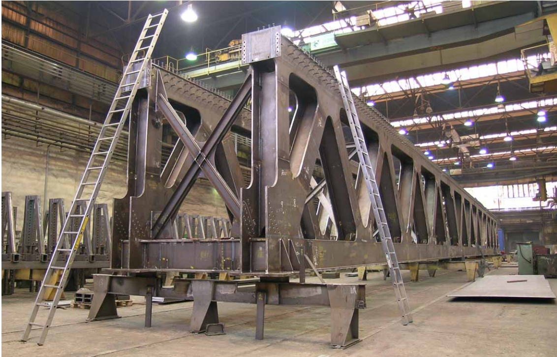
Obr. 3 Rozpracovaná ocelová konstrukce v mostárně MCE Slaný
