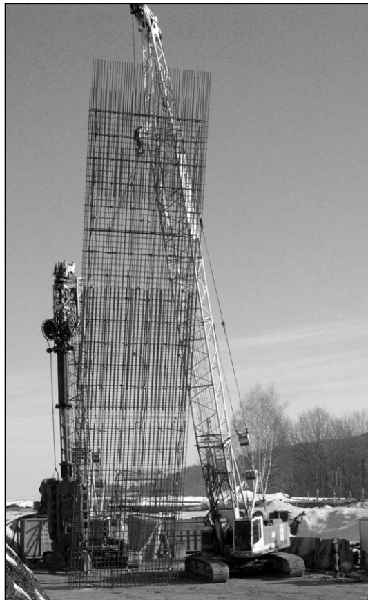
Obr. 3 – Manipulace s armokošem
