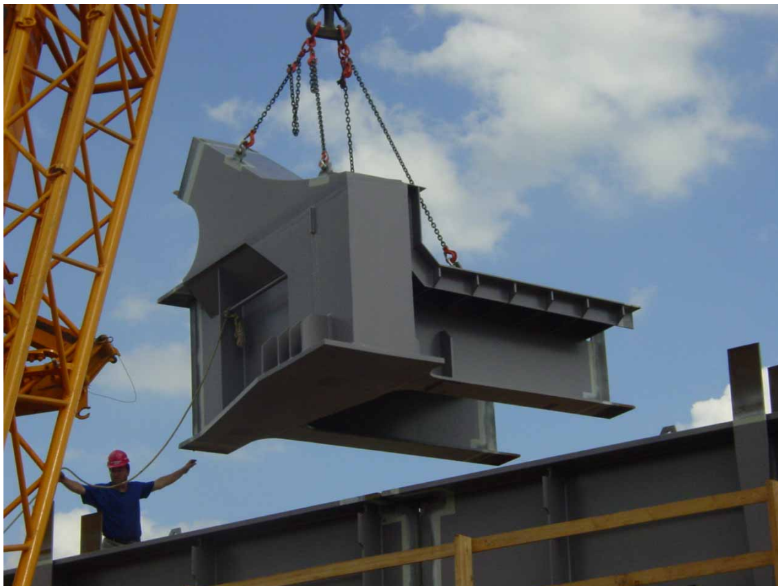
Obr. 3 Přechodový díl trám x oblouk se zárodkem příčnicku
