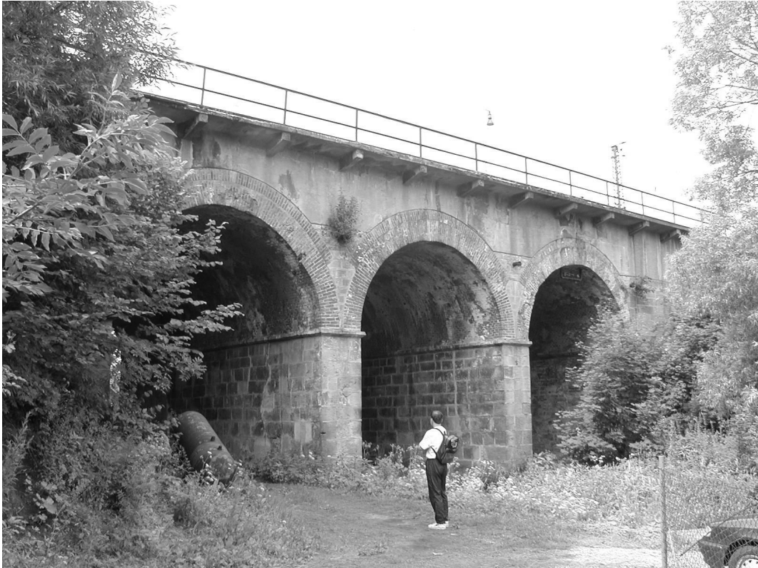
Obr. 5 Původní nosná konstrukce – pohled zleva
