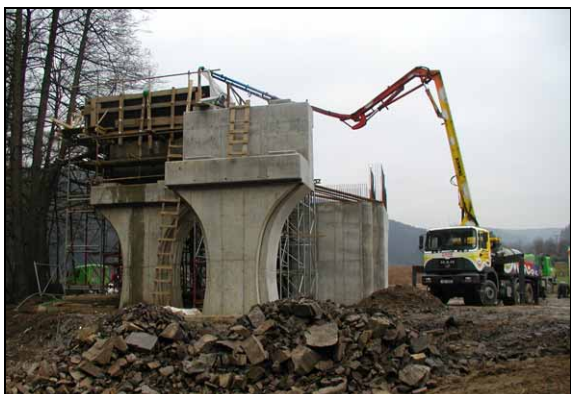
Obr. 3 Pohled na třebovské pilíře a opěry
