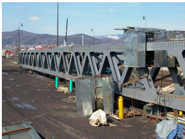
Svařování na předmontážní ploše
