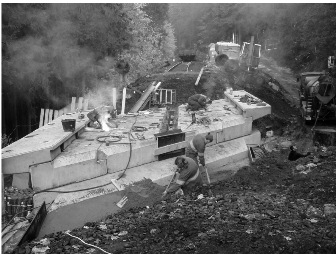
Obr. 5 Pohled na montovanou nosnou konstrukci
