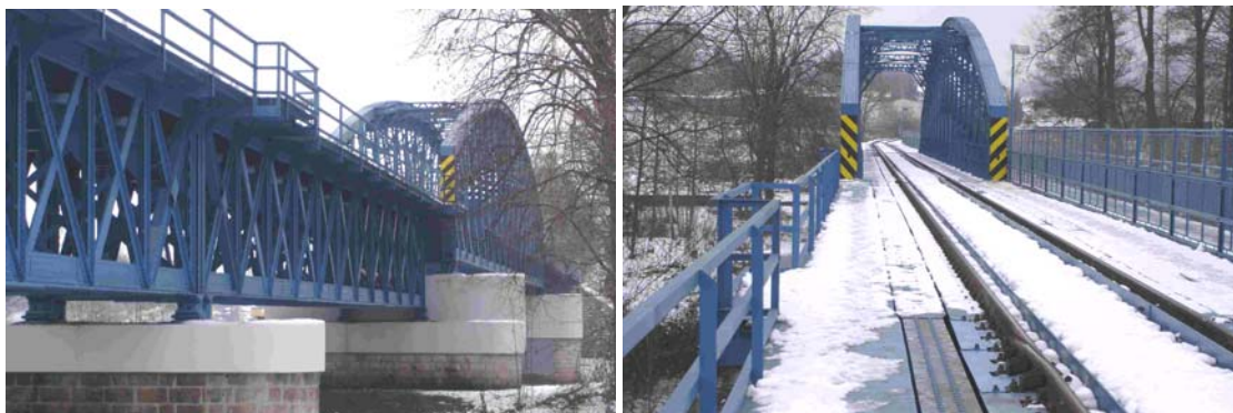
Most po rekonstrukci
