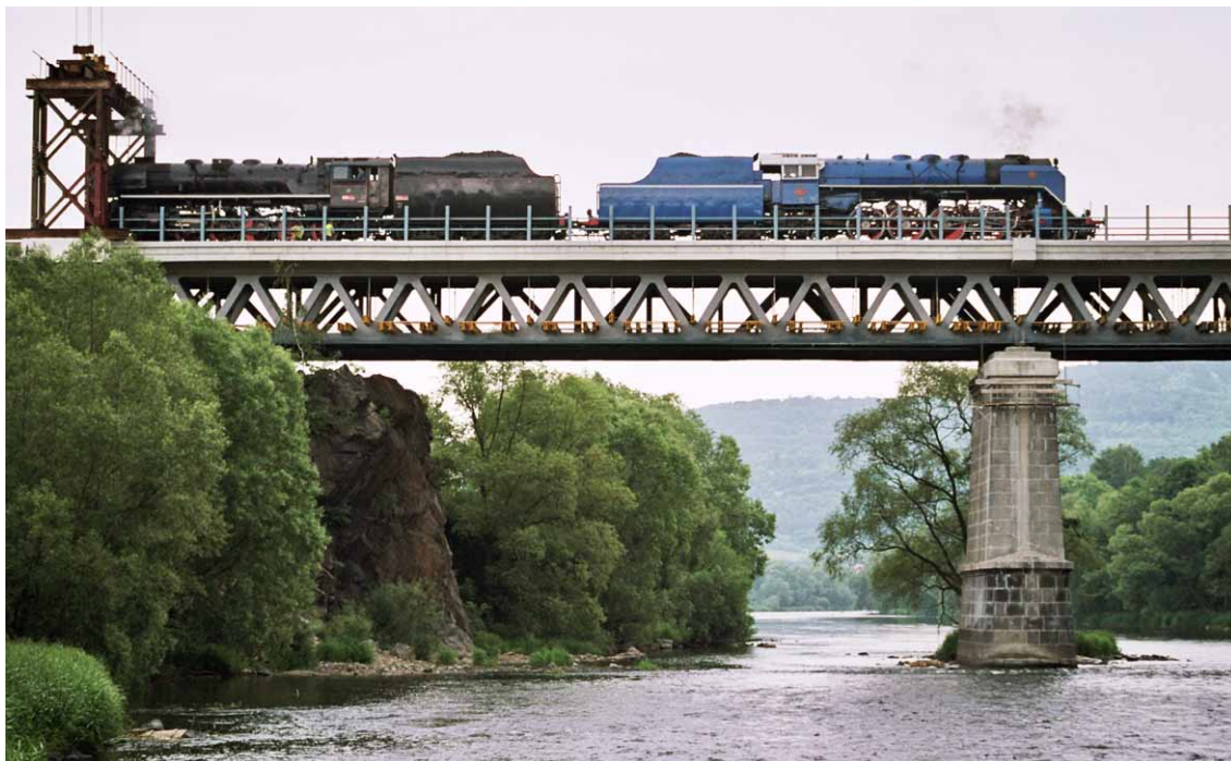
Obr.7 Parní lokomotivy při zatěžovací zkoušce 1. pole mostu ve 2. koleji.
