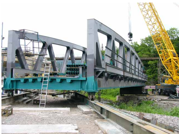
Montáž ocelové konstrukce – fáze 1
