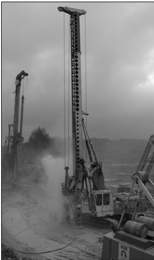
Obr. 4 – Hloubení vrtu přes žulové ostění
