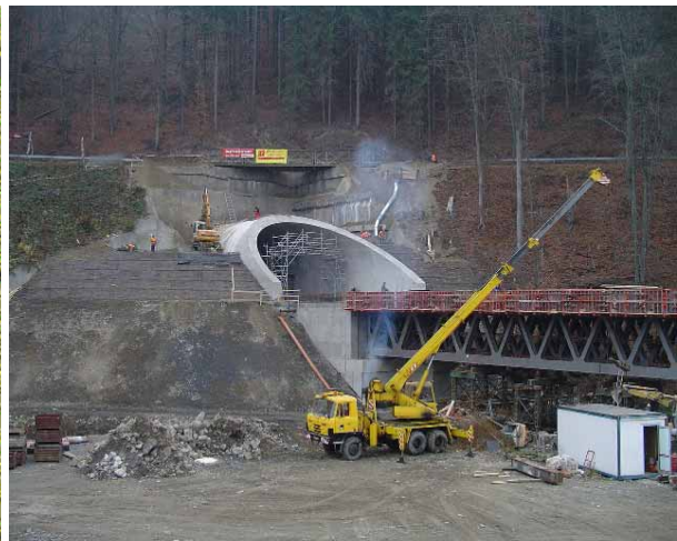
Obr. 6. Realizovaný výjezdový portál tunelu Hněvkovský II. s použitím geomříží TENSAR
