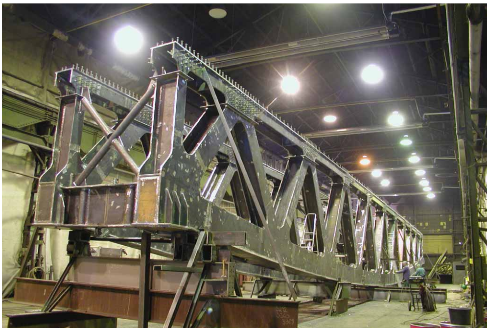
Obr. 7 Vyrobená konstrukce hlavního pole pro kolej č.1 při montážní přejímce
