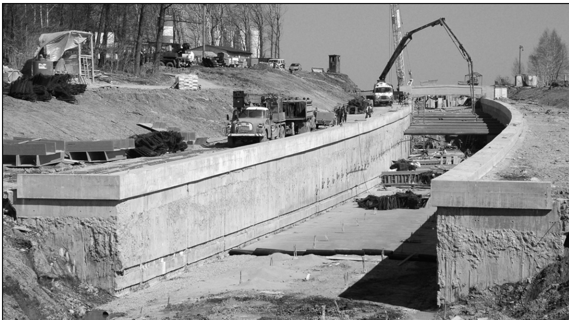
Obr. 6 – Pohled na třebovické zárubní zdi a tunel v době výstavby
