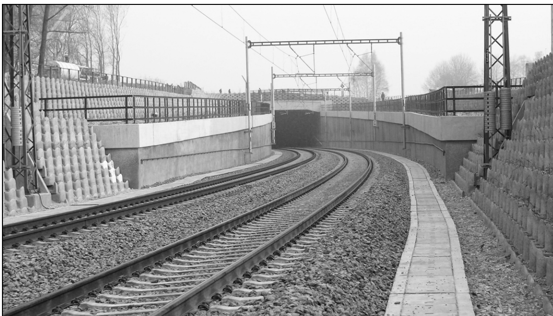
Obr. 7 – Pohled na třebovické zárubní zdi a tunel po uvedení do provozu
