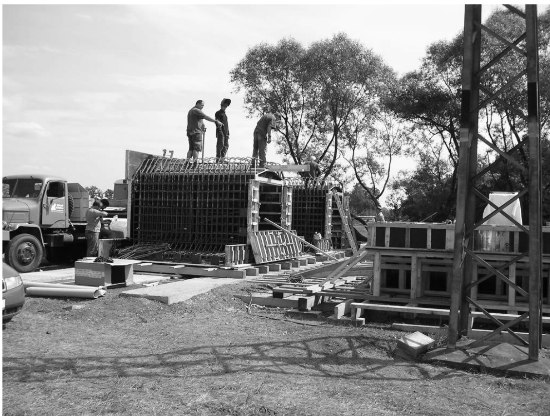
Obr. 3 Výroba prefabrikátů
