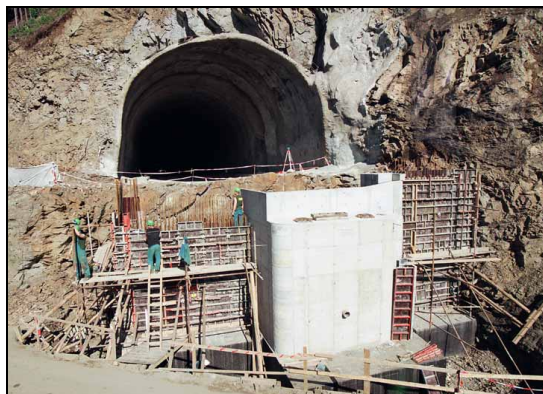
Obr. 4 Provádění olomoucké opěry
