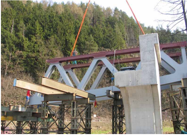
Montáž OK pomocí autojeřábu nosn. 220 t.
