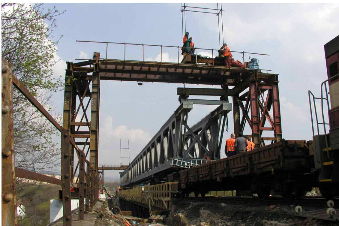
Obr. 6 Zvedání nové konstrukce z přepravního podvozku
