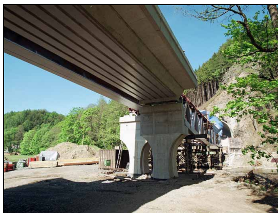
Obr. 6 Nosná konstrukce třebovského předpolí v koleji č.1
