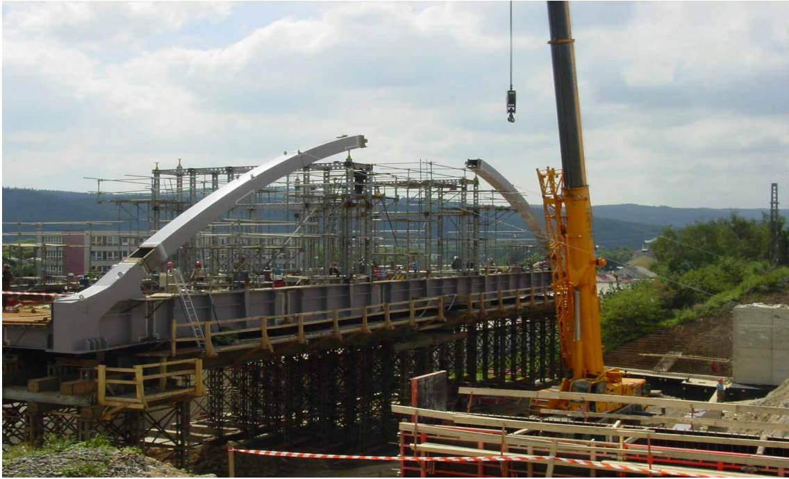
Obr. 4 Montáž nosné konstrukce před příčným zásunem
