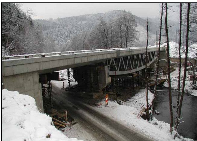
Obr. 11 Pohled na most před dokončením
