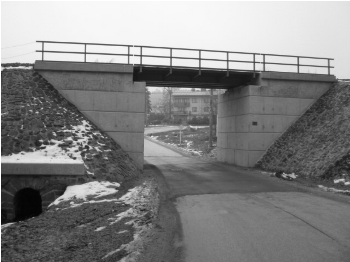
Obr. 2 Most po opravě
