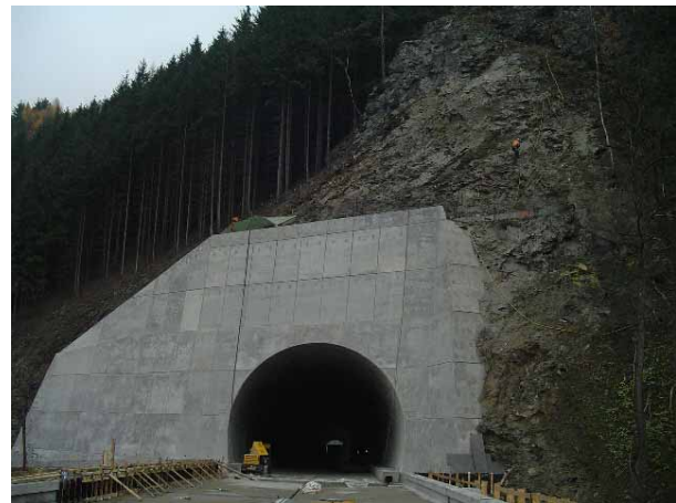
Obr. 4. Zabetonovaný vjezdový portál tunelu Hněvkovský II.
