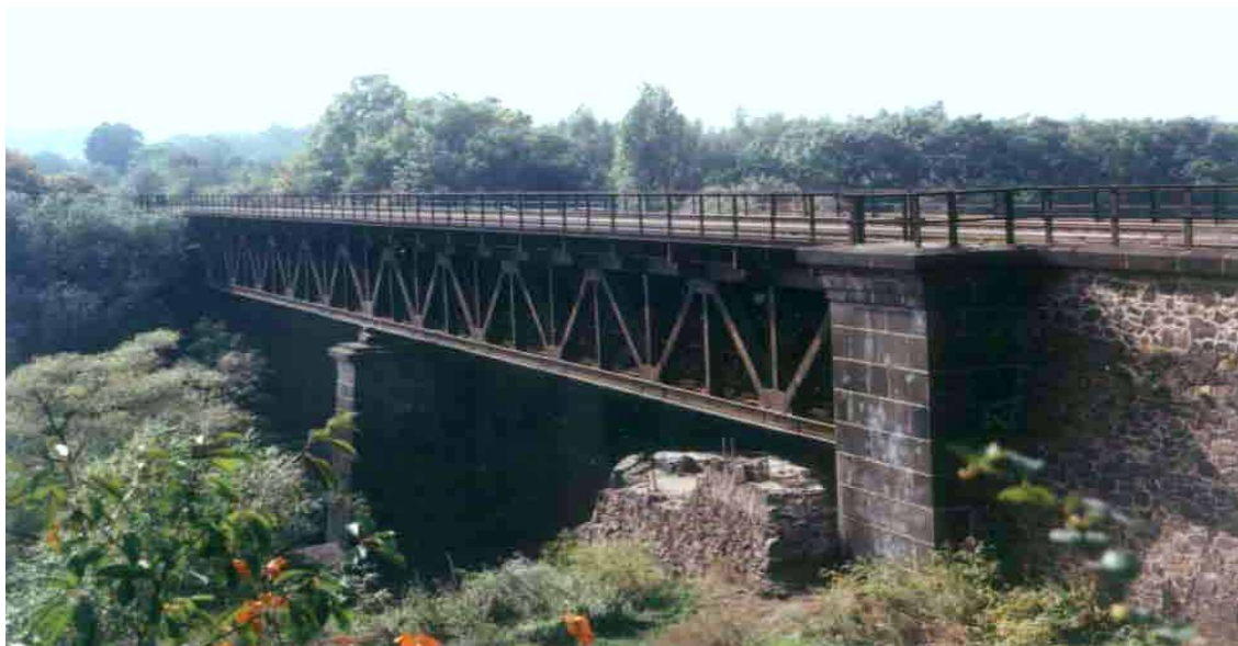
obr. 1 Pohled na původní most v koleji č. 1 z levé strany
