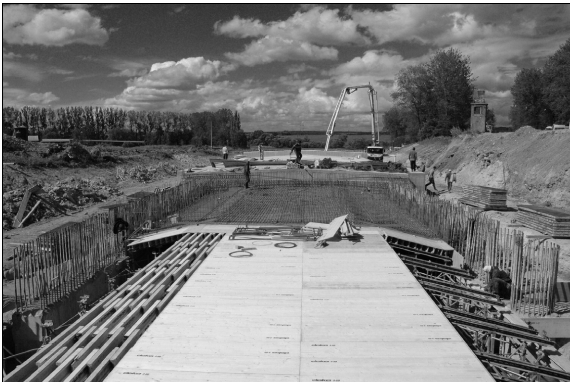
Obr. 5 – Pohled na výrobu stropních desek
