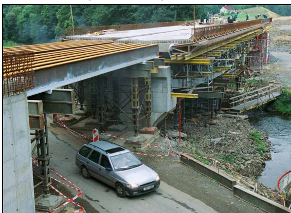
Obr. 5 Montáž nosníků olomouckého předpolí
