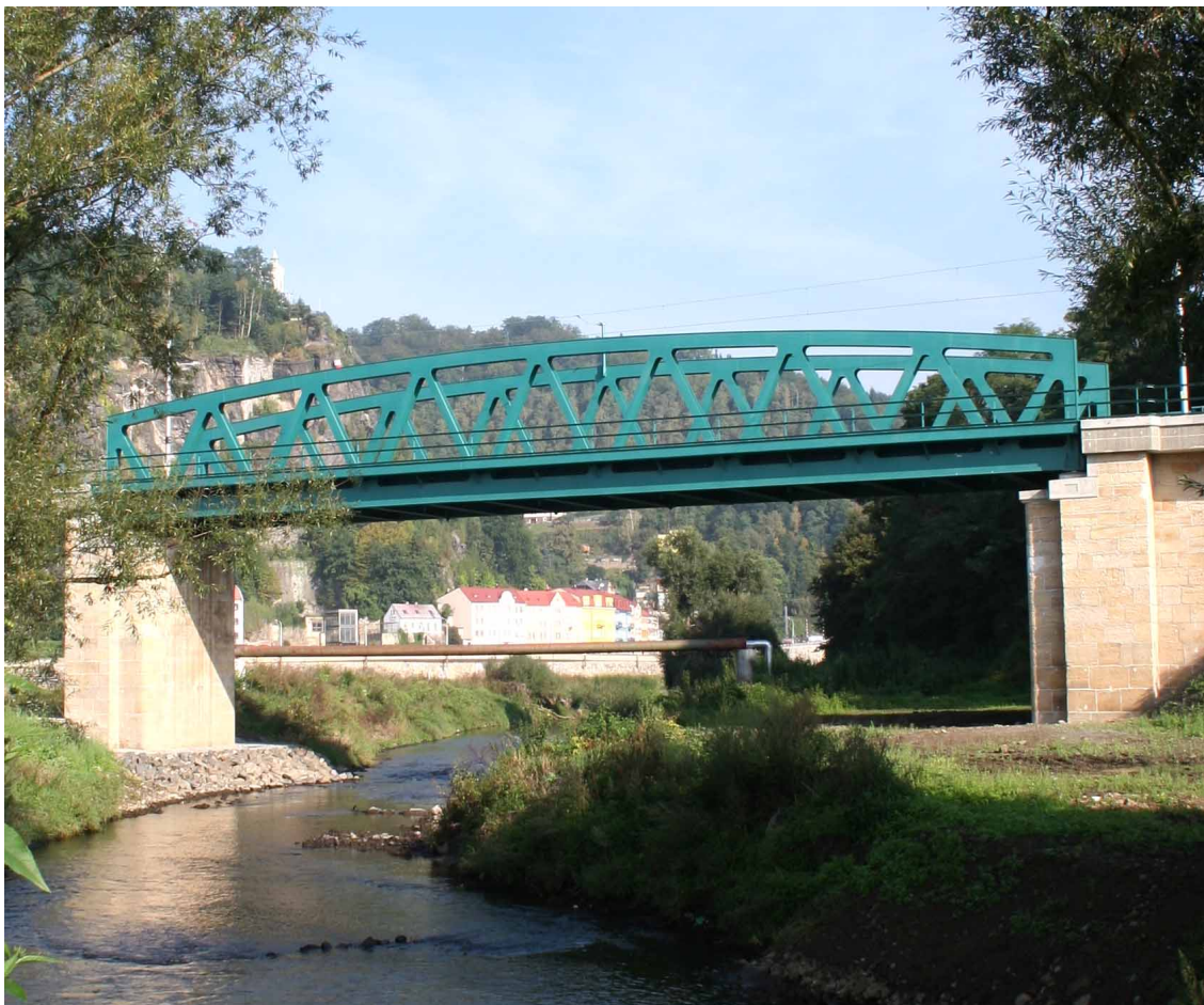
Obr.1 Pohled na dokončený most
