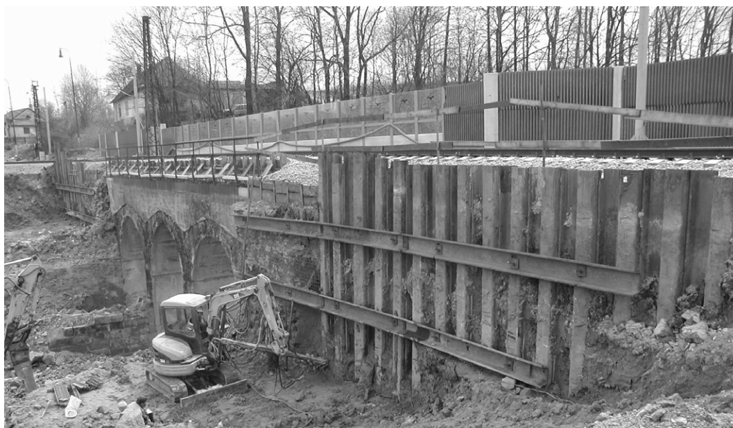
Obr. 4 Pohled na klenbu na konci první stavební fáze
