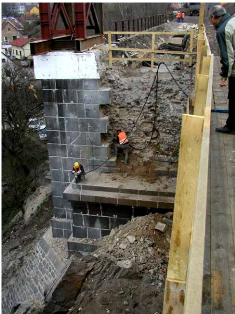
Obr. 4 Bourání chomutovské opěry
