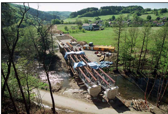
Obr. 10 Celkový pohled na prostor staveniště ve fázi svařování osazených montážních dílů hlavního pole
