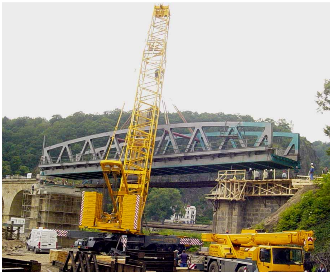
Obr.4 Osazení nové OK do otvoru mobilním jeřábem Liebherr 1550
