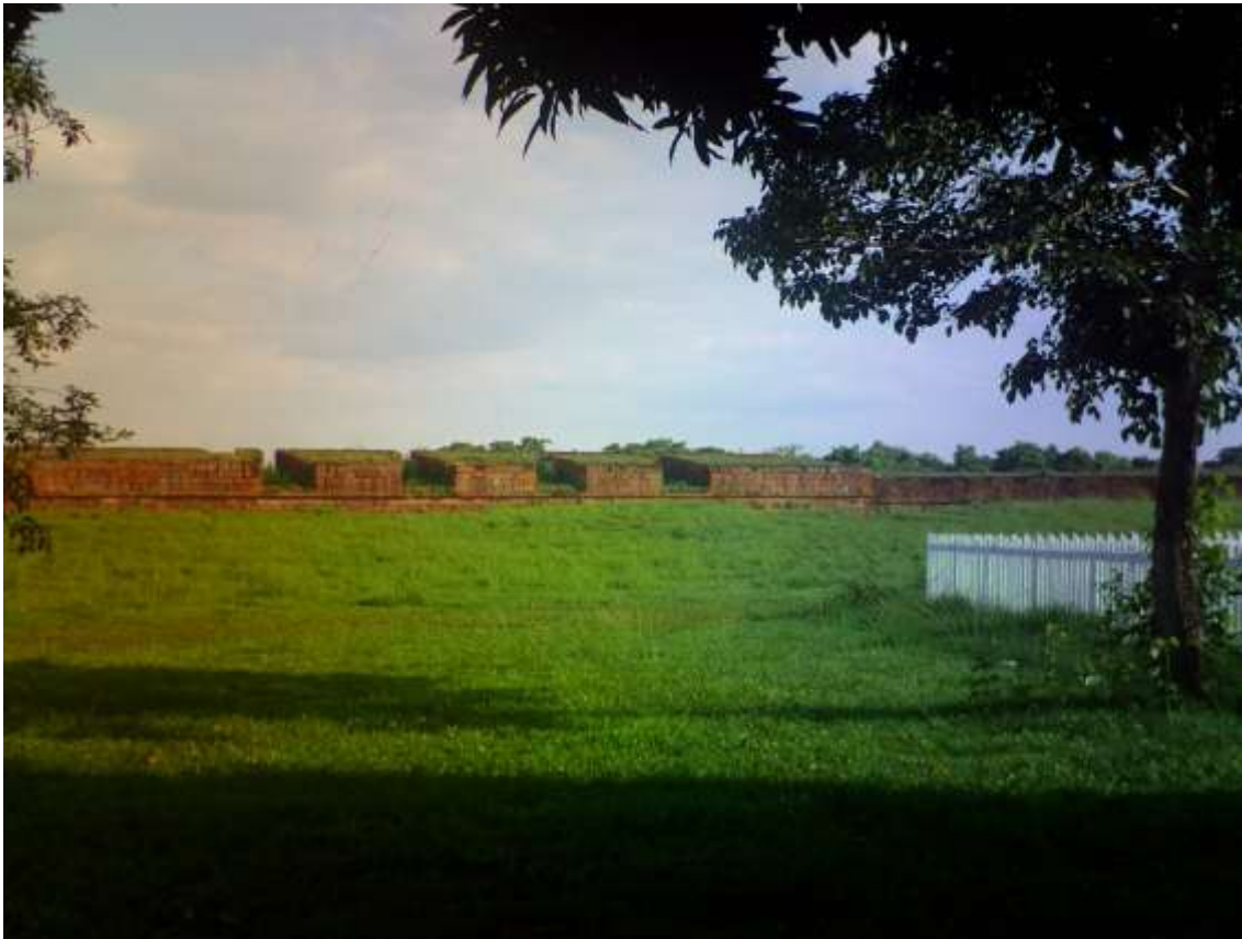
Muralhas do Forte Príncipe da Beira em Costa Marques – RO. Foto da autora.
