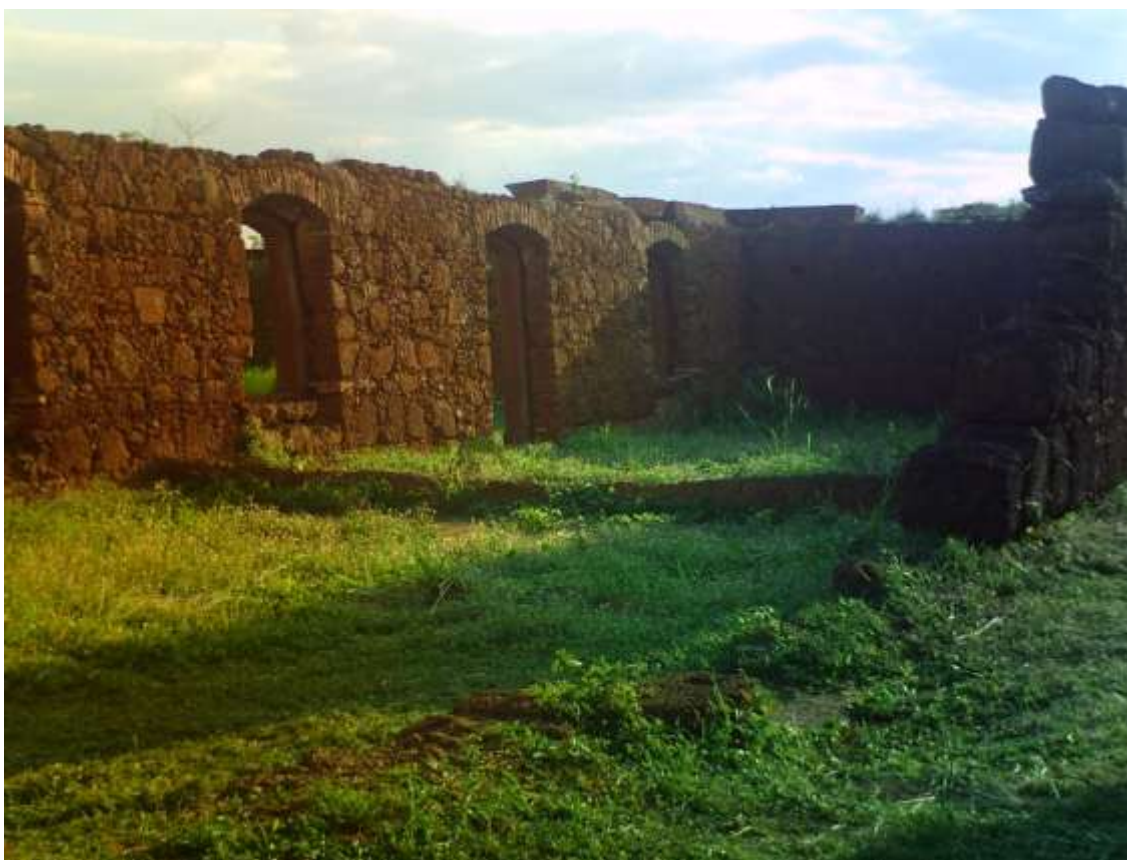
Parte interna do Forte Príncipe da Beira em Costa Marques - RO. Foto da autora.
