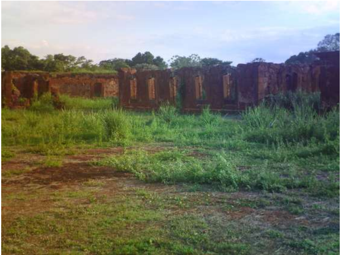
Muralhas parte interna Forte Príncipe da Beira- RO. Foto da autora.
