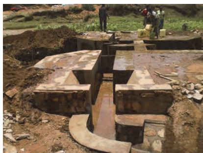
Prise 2, en construction
