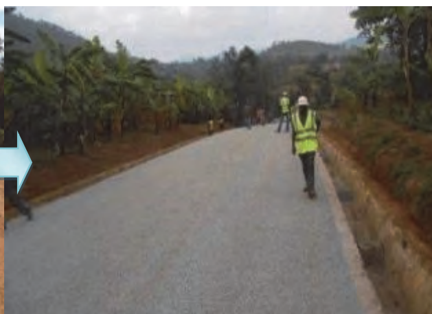
(Après) La réhabilitation de route
