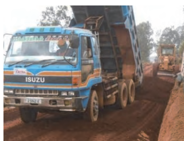
Placement du latérite
