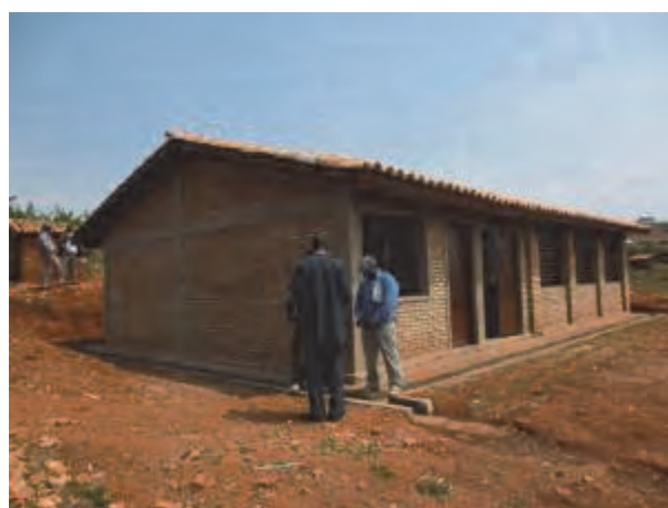
Bâtiment des travaux de menuiserie du PP8
