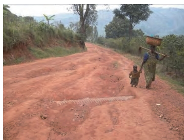
Route en mauvais état vers Bukirasazi
