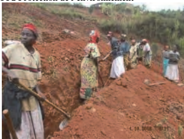
Creusement de courbes de niveau pour la fixation d'herbes
