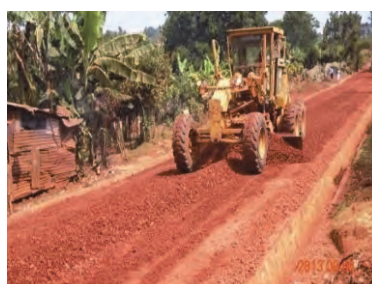
Pavement du latérite
