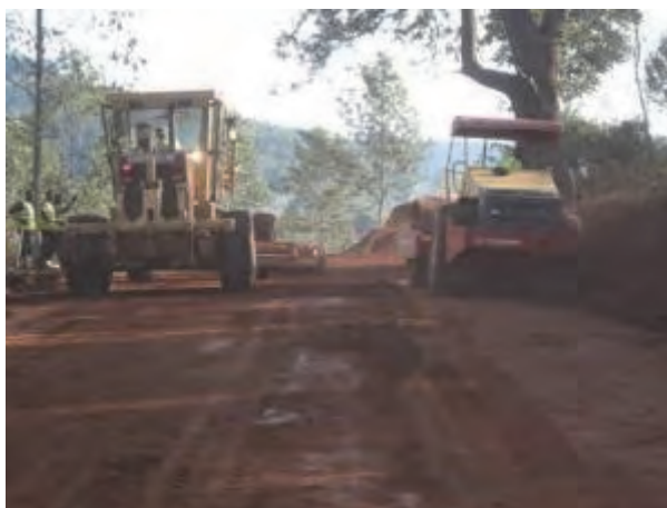
Travaux d'aménagement avec niveleuse et compacteur
