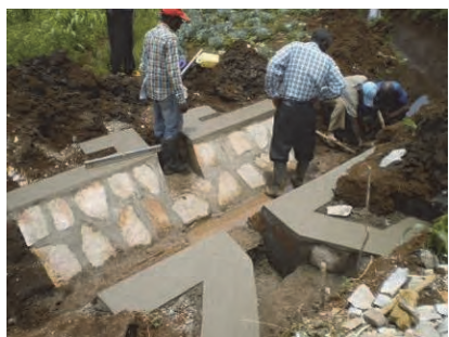
Déversoir en finition
