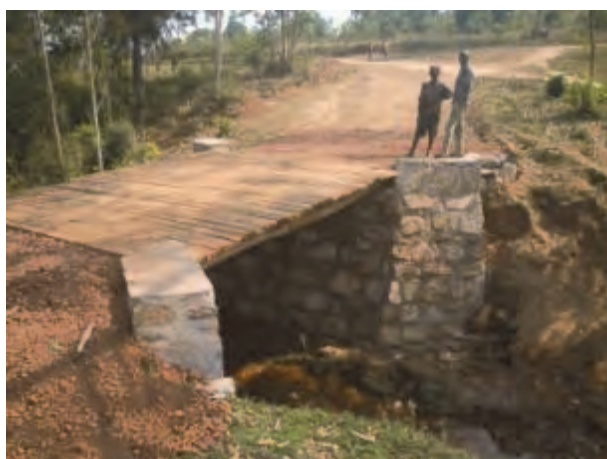
Pont construit du PP7
