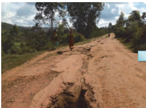
(Avant) La réhabilitation de la route
