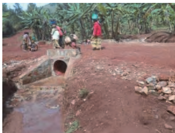
Buse construite du PP7
