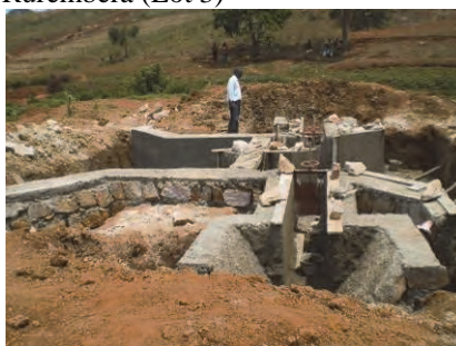
Prise d'eau 2 en construction
