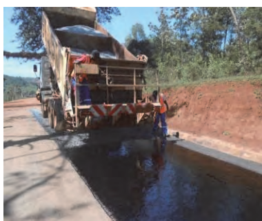
Repandre le bitumen et granulats
