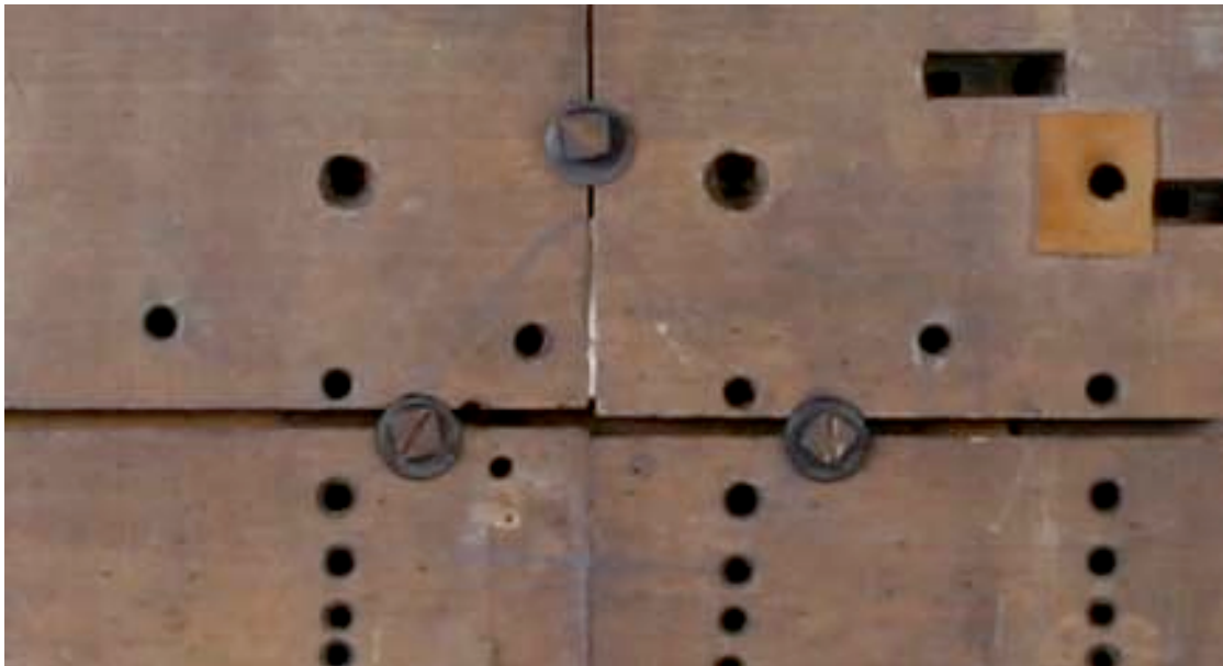
Abbildung 101 Schrauben mit Unterlegscheibe fixieren jeweils zwei auf Stoß liegende Stöcke
