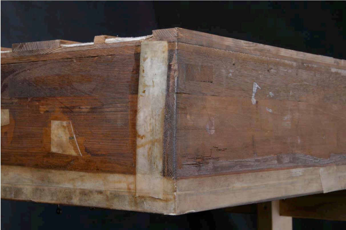
Abbildung 88 Kanzellenrahmen und Windkasten
