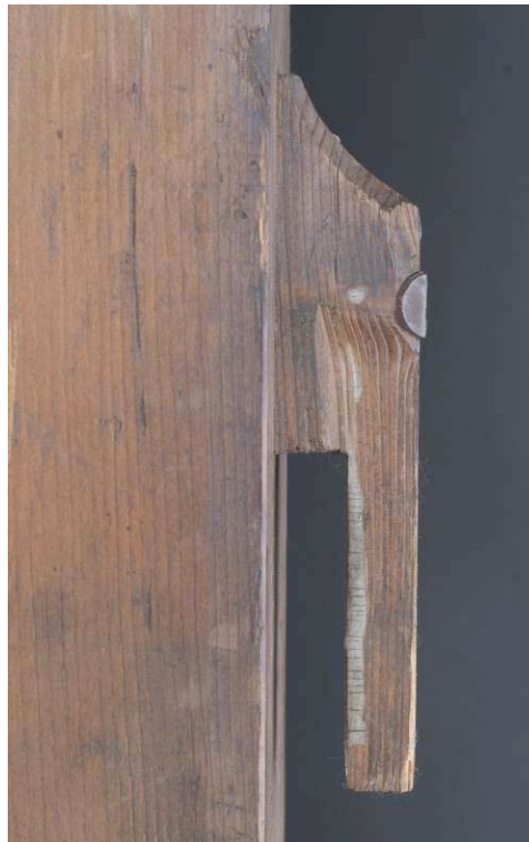
Abbildung 59 originaler Haken der Anhängung bei D
