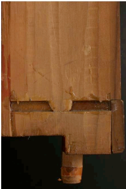
Abbildung 40 Ausgehobelte Seitenwand bei F
