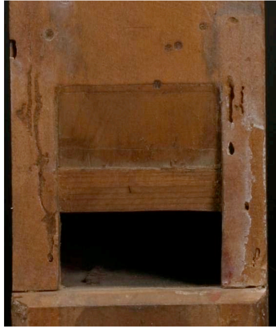
Abbildung 43 Aufschnitthöhe mit Leiste verringert bei h^\circ
