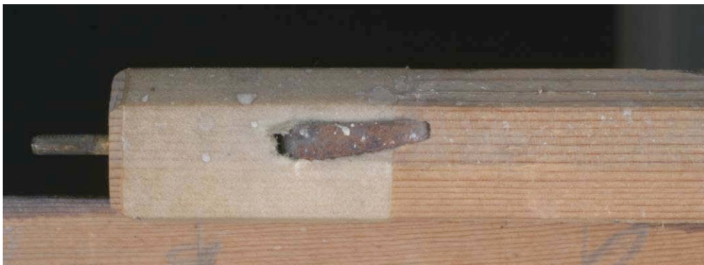
Abbildung 128 Umgenietetes Ende des Abzugsärmchens in der Welle
