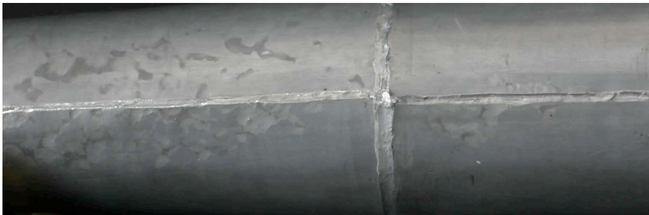
Abbildung 5: Lötnaht Propektpfeife Gabelbach
