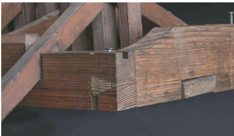
Abbildung 183 Verzinkter Rahmen Wippenwerk
