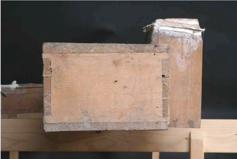
Abbildung 204 Sammelkanal, eingezinkte Stirnwand, Kropf mit breit abgefasten und belederten Kanten bei der Öffnung
