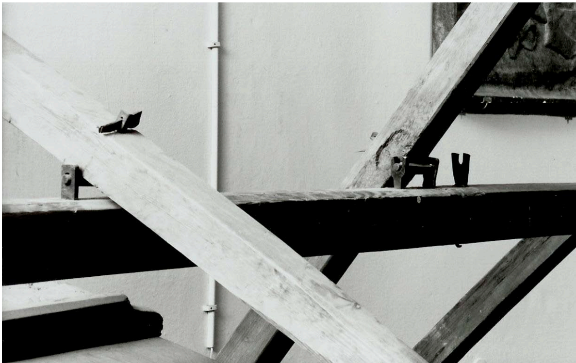
Abbildung 200 Befestigung der Handhebel auf dem Lagerbalken
