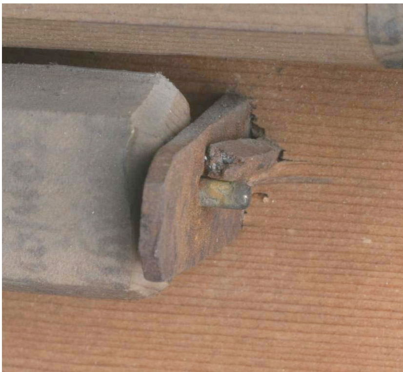
Abbildung 133 Drahtstift mit rechteckigem Querschnitt
