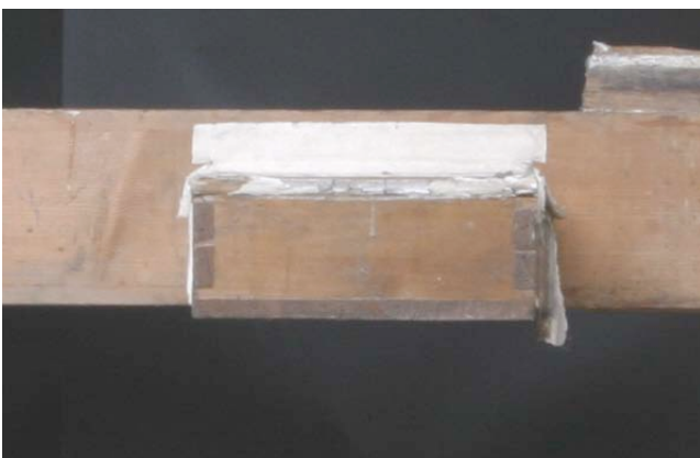
Abbildung 206 Veränderung der Position des unteren Winkelstücks des senkrechten Zubringerkanals am liegenden Sammelkanal: Der breite weiße Ledersteifen dichtet die ursprüngliche, höher liegende Öffnung für das Winkelstück im liegenden Sammelkanal ab.
