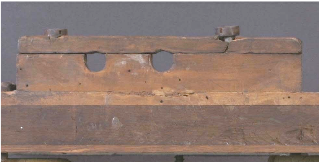
Abbildung 144 Lager der Registerwellen auf den Stöcken
