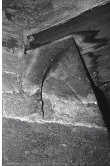
Abb. 15: Kämpferstein in Muqarnas, Cappella Palatina, Palermo, Unterkirche, südöstlicher Chorungang
