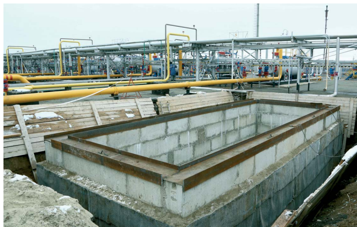
Подготовка фундамента для дренажной емкости
