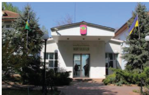
Адміністративна будівля Південної митниці
