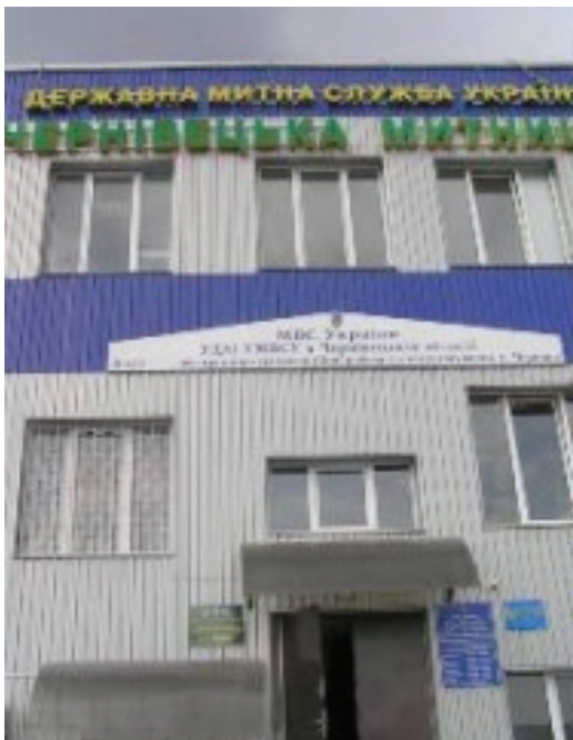
Адміністративна будівля Чернівецької митниці
