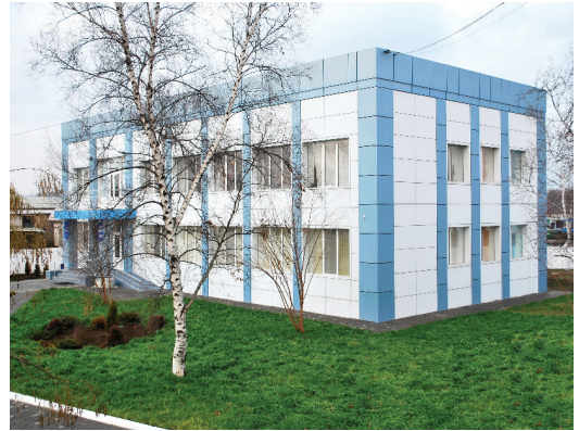
Митний пост «Херсон-центральный». Загальний вигляд будівлі, у якій розташований підрозділ митного оформлення
