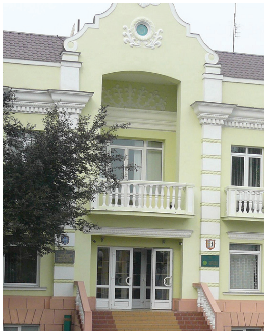
Адміністративна будівля Чопської митниці
