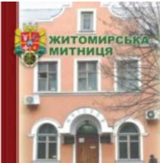
Адміністративна будівля Житомирської митниці
