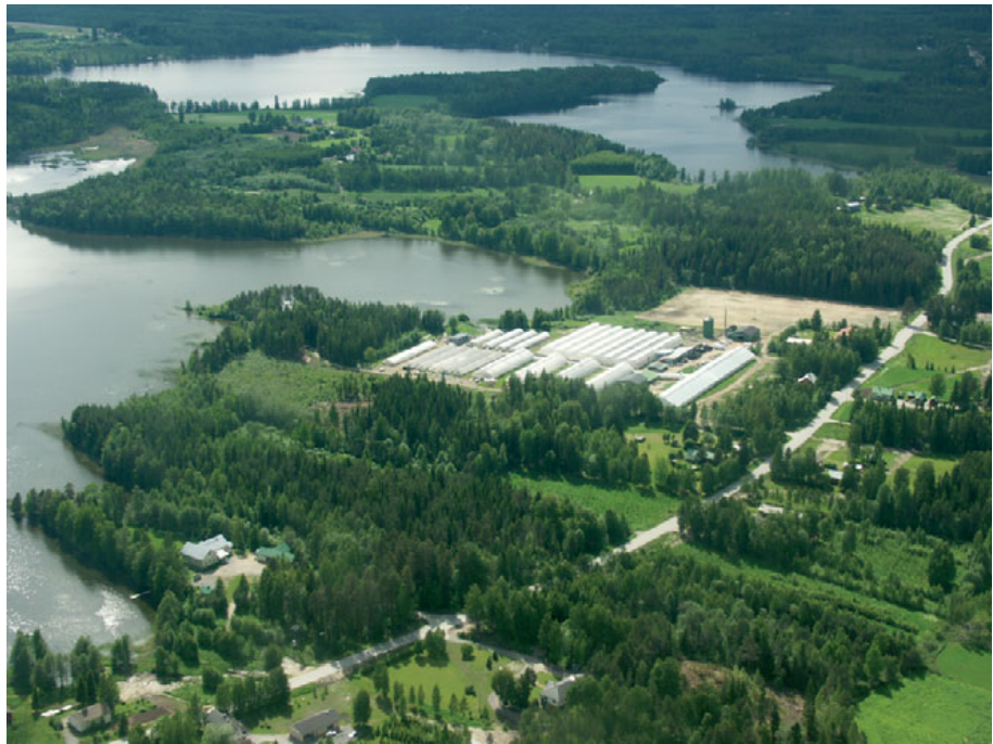
Kuva 4.1 Reetantarhan kasvihuoneet sijaitsevat Lihavanpään keskeisellä paikalla lähellä Lihavan rantaa.
