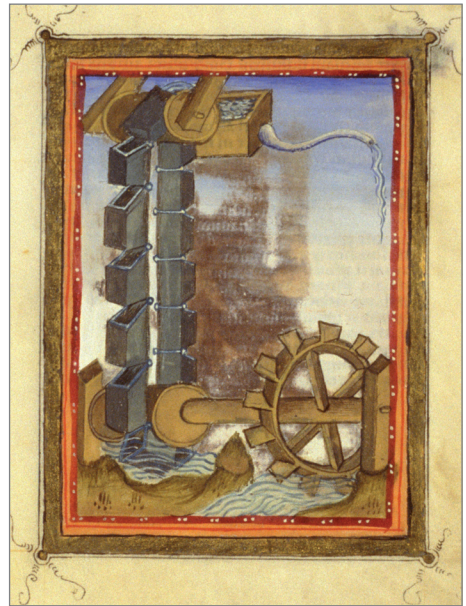
Abb. 3 Kap. 12: Behälterkette von Gruter erbaut für den Bischof von Modena ca. 1400–1401
