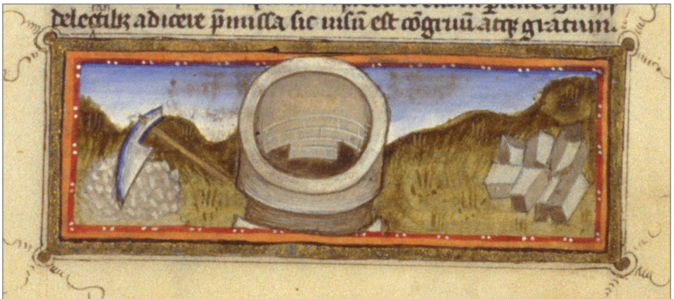
Abb. 5 Kap. 22: Brunnen-schacht-Vermauerung von oben
