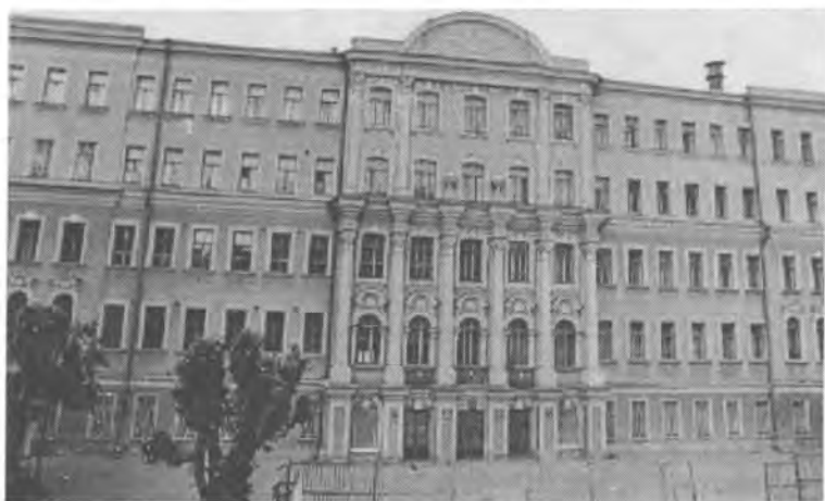
Здание Петришуле. Построено в 1760–1762 гг. Надстроено в 1799, 1876–77, 1913–1915 гг. Невский проспект д. 22–24. Современный вид
